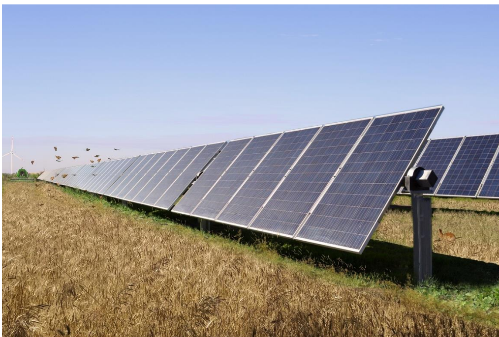
Figura 15 - Sezione tipo coltivazione cereali tra le fila delle strutture fotovoltaiche
