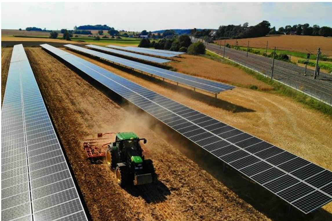
**Figura 15 -** Movimentazione di mezzi agricoli sotto i Tracker
