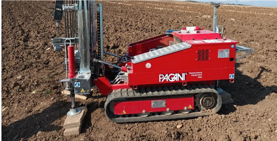
Postazione della prova Dpsh 03
