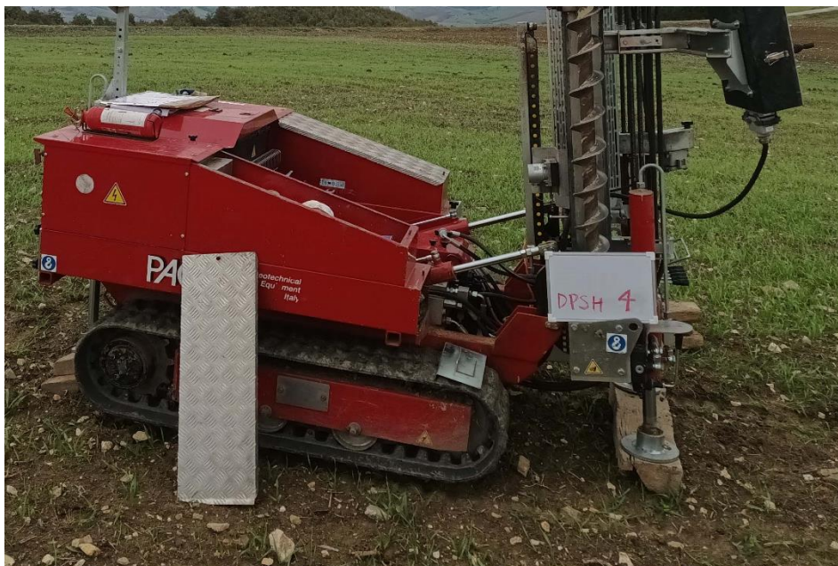
Postazione della prova Dpsh 04
