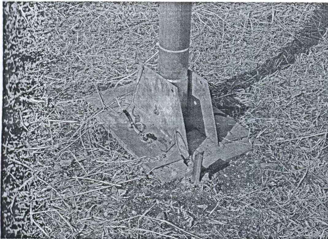
PARTICOLARE PIASTRA DI APPOGGIO
