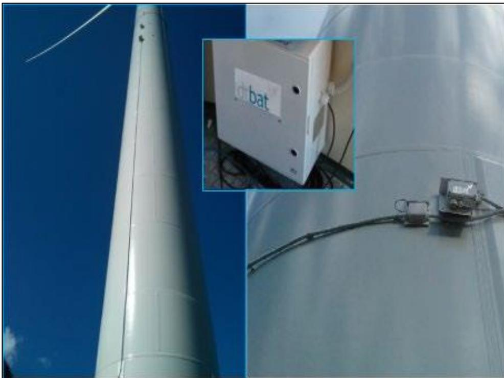
Figura 46: Esempio di sistema automatico installato su aerogeneratore al fine di limitare il rischio di collisione
