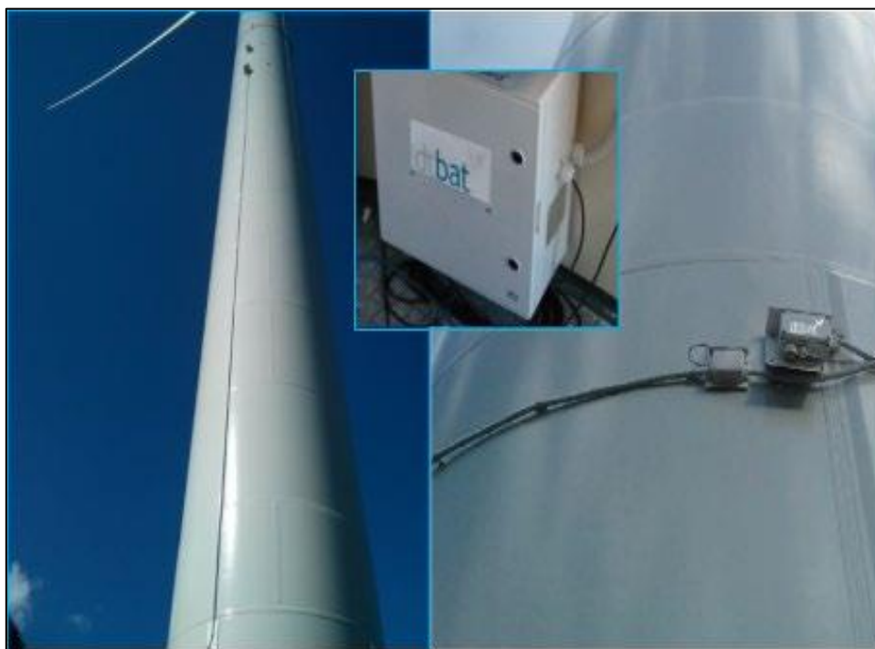
Figura 60: Esempio di sistema automatico installato su aerogeneratore al fine di limitare il rischio di collisione
