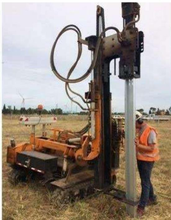
**Fig. 78\_** Esempio di supporto costituito da palo in acciaio infisso direttamente nel terreno mediante battipalo
