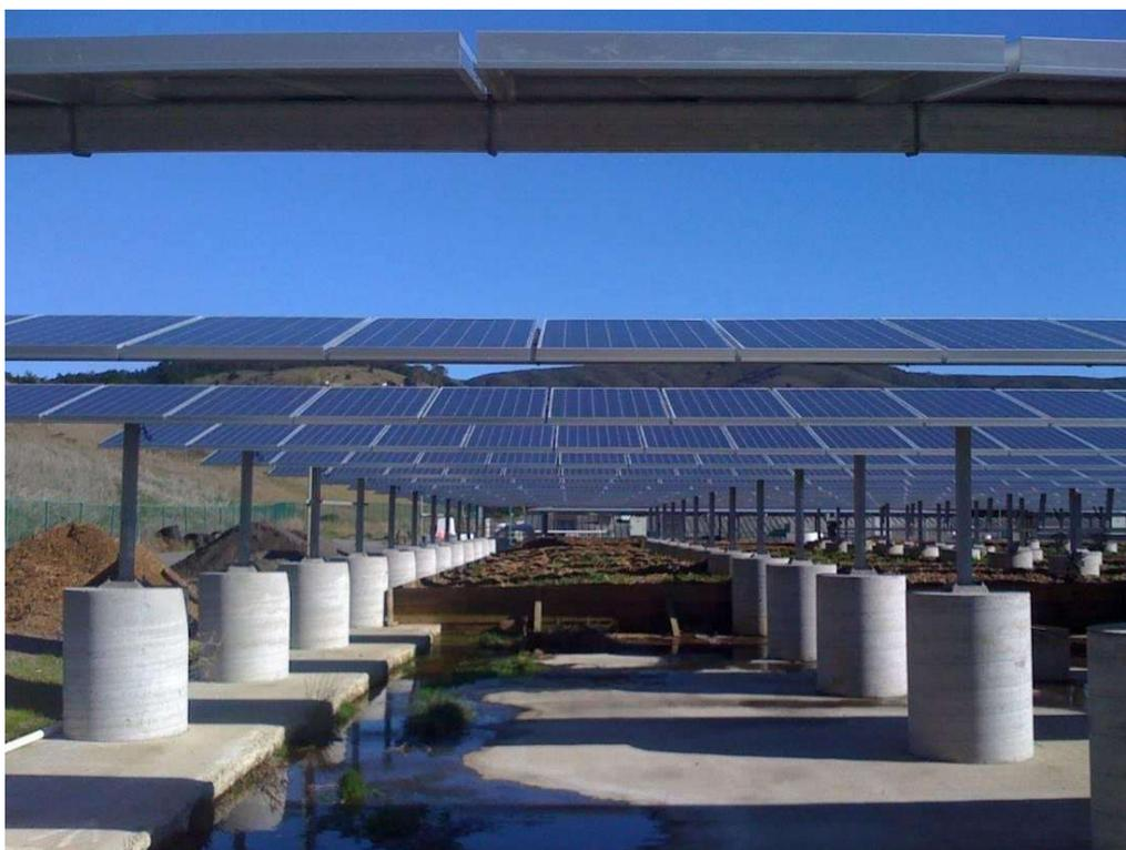
**Fig. 80\_** Esempio di impianto fotovoltaico con fondazioni formate da zavorre costituite da plinti in cemento
