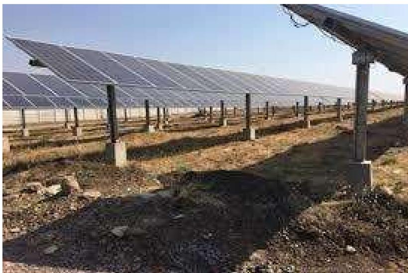
**Fig.79 \_** Esempio di impianto fotovoltaico con fondazioni ottenute mediante perforazione del terreno e
