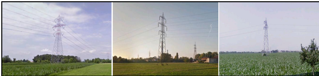
Figura 4.2.8.6d Linee Elettriche Presenti nell’Area di Studio a 380 kV, 220 kV e 132 kV
