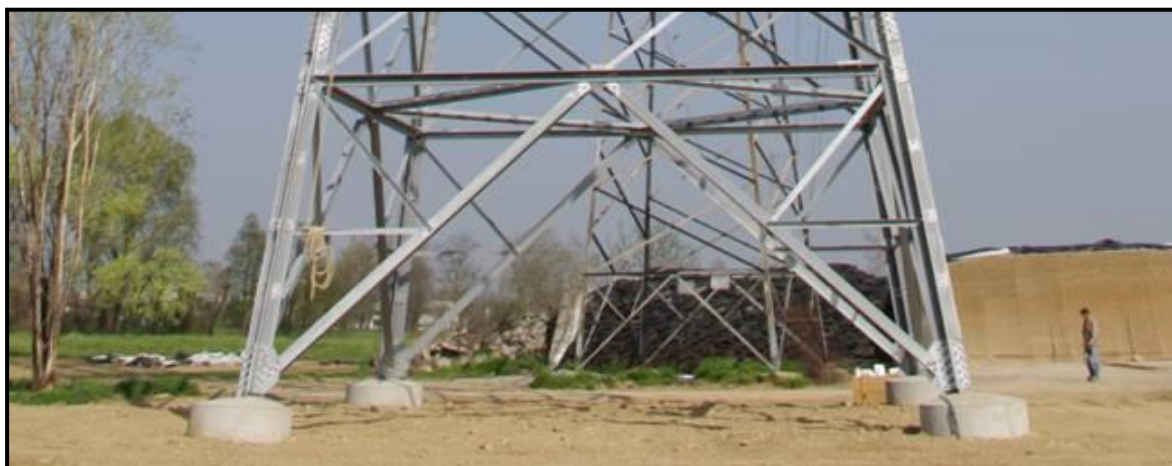
Figura 4.2.8.6a Base del Sostegno Reticolare a Traliccio
