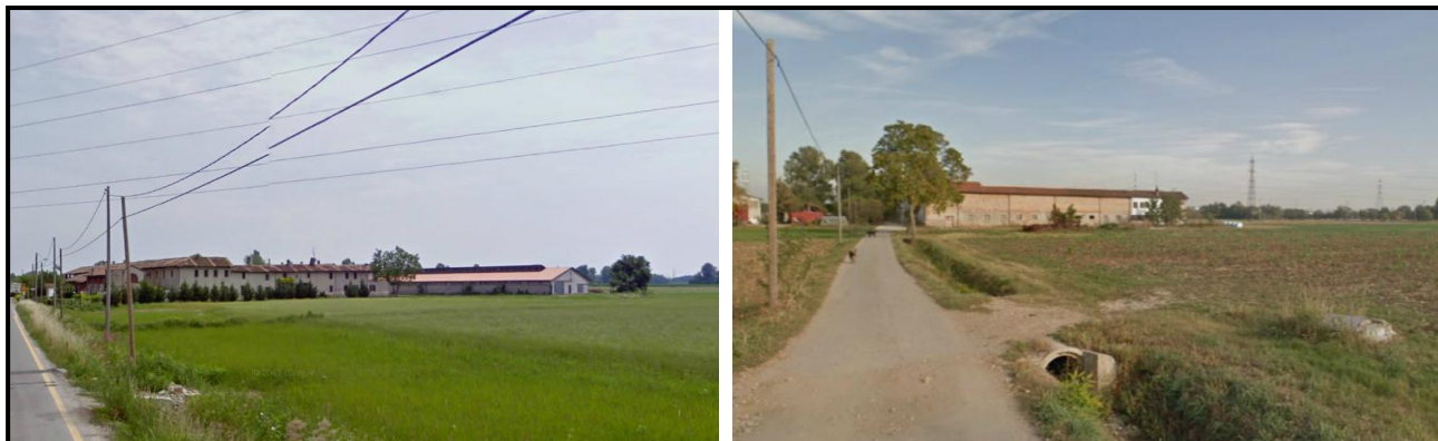
Figura 4.2.8.3c Esempi di Cascine nei Pressi del Tracciato dell'Elettrodotto
