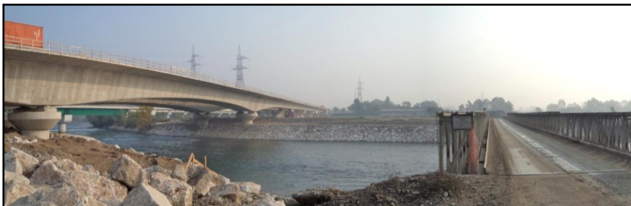
Figura 4.2.8.3b L'attraversamento del Fiume Adda del Cantiere delle Infrastrutture
