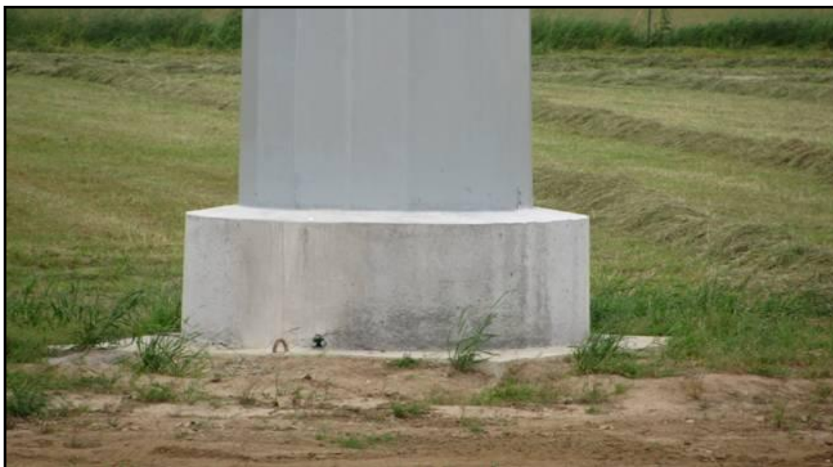
Figura 4.2.8.6b Base del Sostegno Tubolare Monostelo
