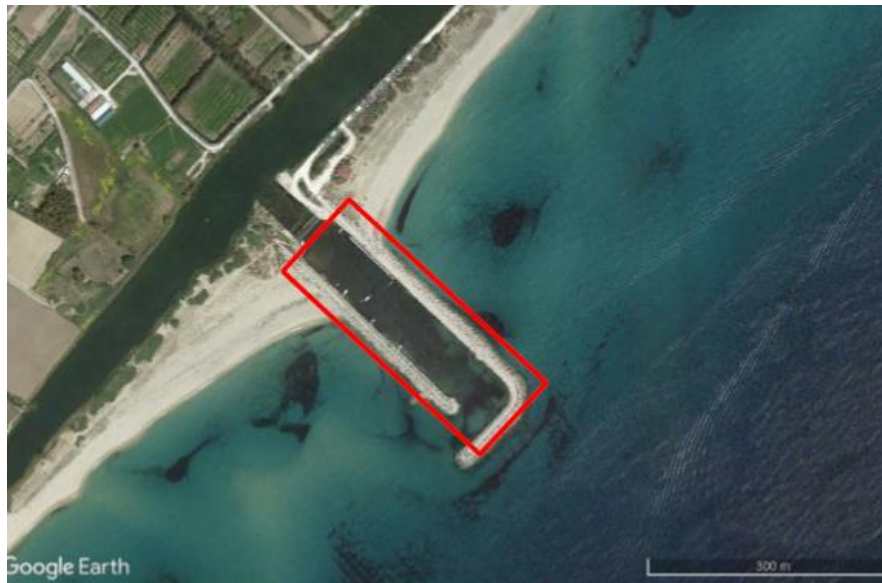
Fig. 1 - Ubicazione dell'area di progetto nella bocca a mare Su Portu della Marina di Orosei.
