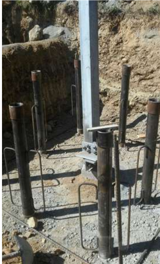
Fig. 22 – Esempio fondazione con micropali. Fonte:
