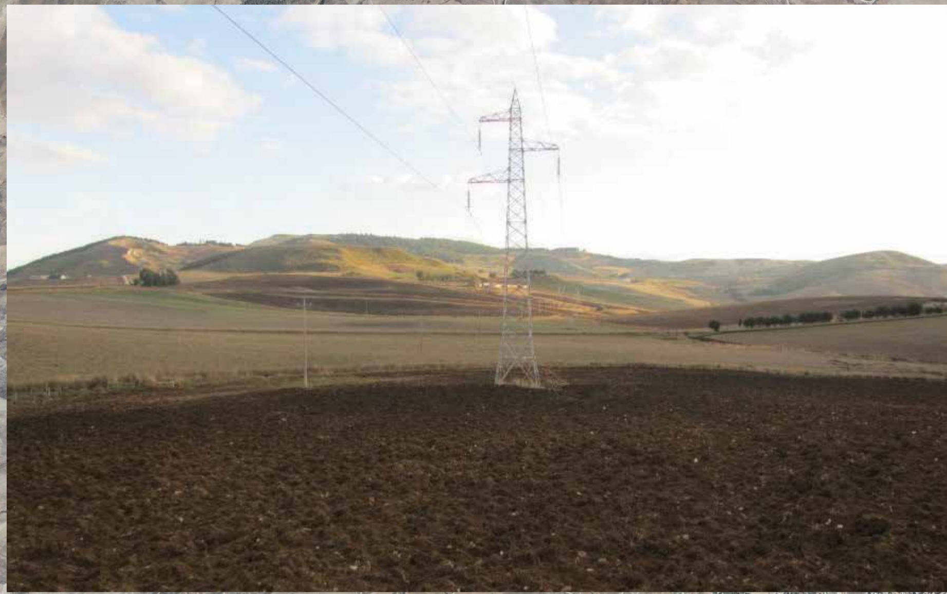
Immagine 1 - Vista del sostegno 166 della linea Vicari-Castronovo
