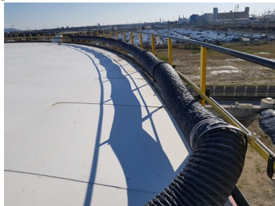
Tubazione di adduzione aria durante il carico del serbatoio
