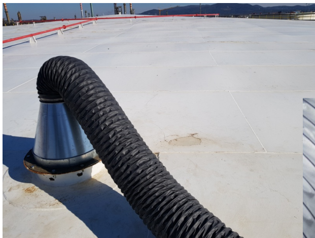
Captazione da serbatoio di stoccaggio olio combustibile
