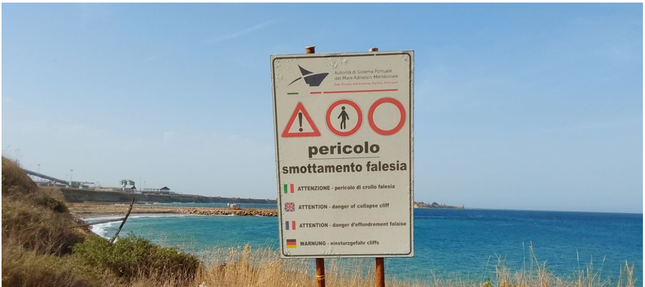
Lo smottamento della falesia del belvedere di Cerano e il segnale di pericolo
