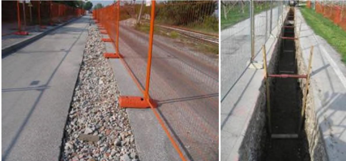
Figura 17 - Taglio dell'asfaltatura e scavo aperto
