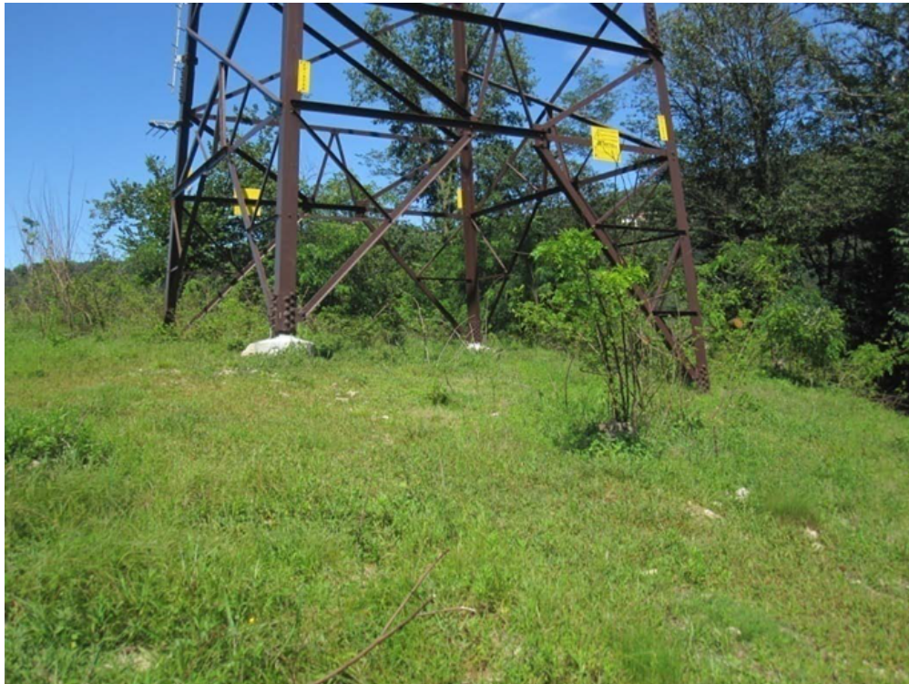
Figura 29 - Interventi di rinaturazione ante e post operam sulle linee 132 kV della Val D'Ossola Sud
