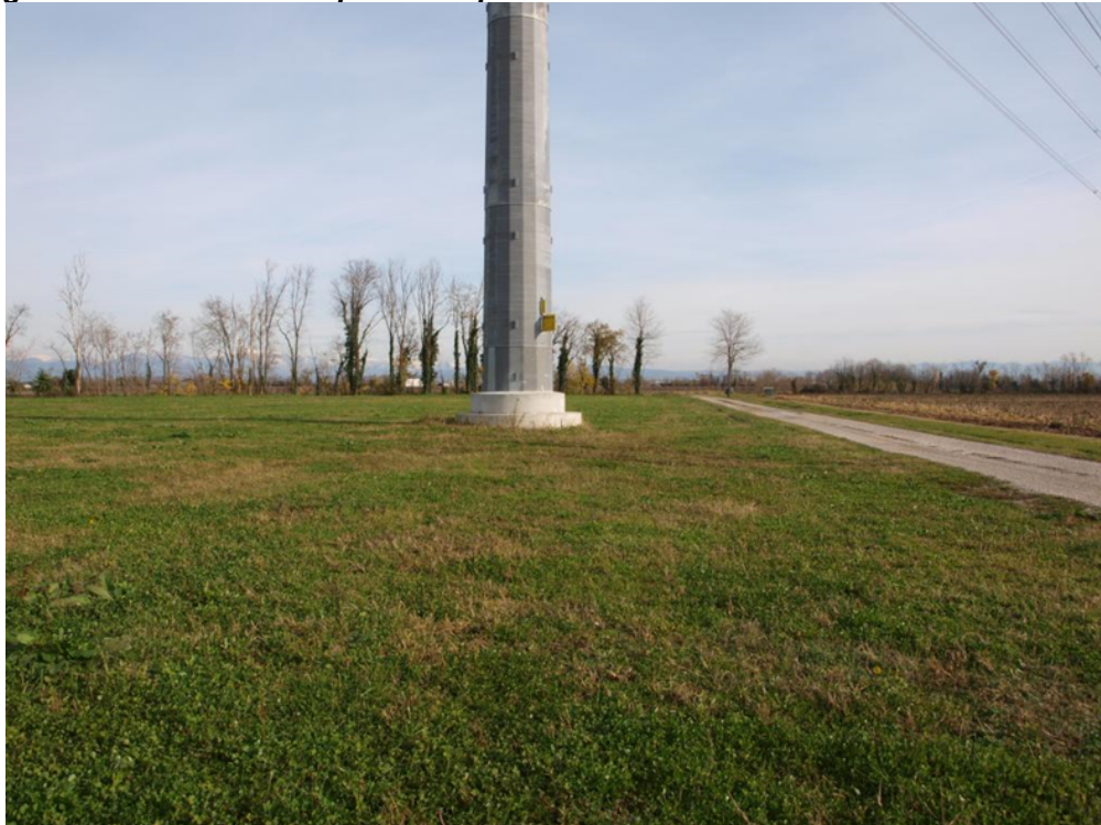
Figura 27 - Intervento di ripristino a prato sulla linea 380 kV Udine Ovest-Udine Sud
