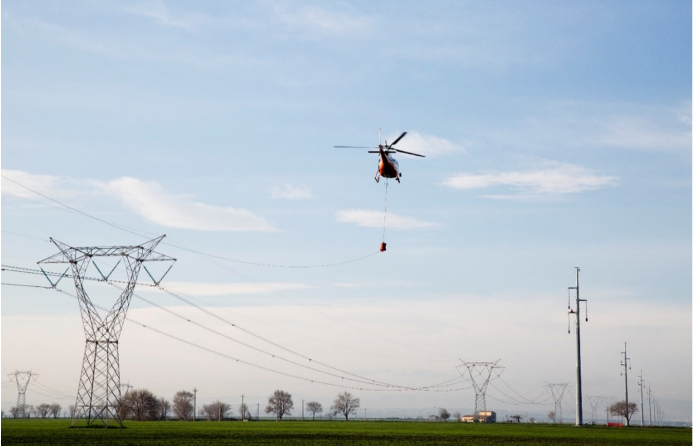
Figura 15 - Fasi di tesatura della linea elettrica
