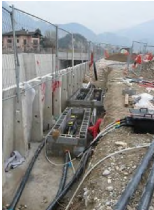
Figura 25 - Esempio di buca giunti
