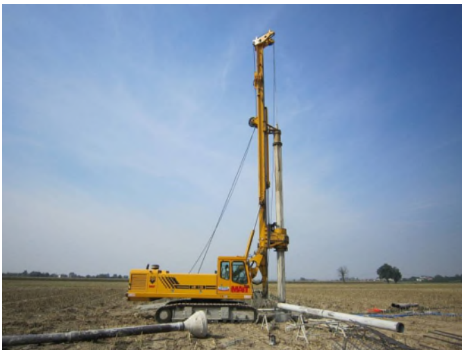
Figura 10 - Macchina operatrice per la realizzazione di pali trivellati
