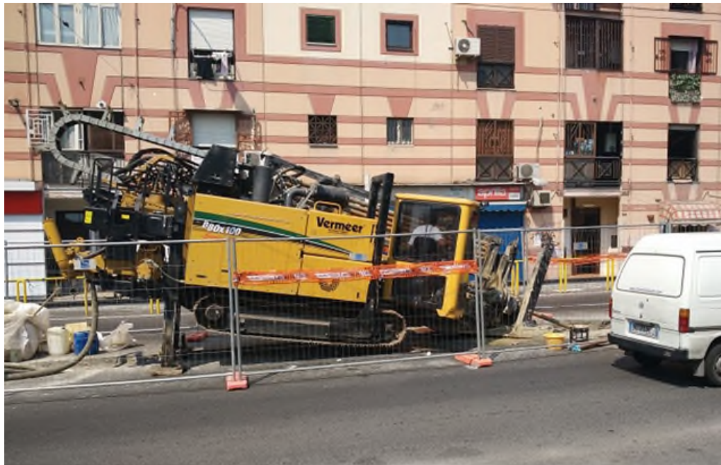
PREDISPOSIZIONE AREE DI CANTIERE PER TOC PER MACCHINA PERFORATRICE
