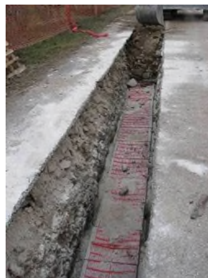
Figura 21 - Rinterro con posa delle piastre di protezione e rete in PVC
