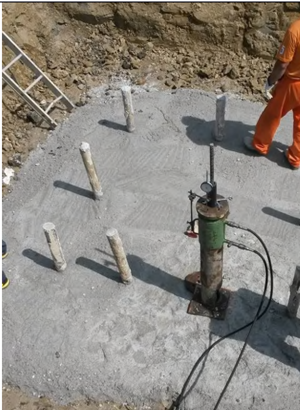
Figura 12 - Realizzazione di micropali tipo tubfix per un sostegno a traliccio; si possono osservare i 9 micropali già realizzati ed iniettati; in questa fase, prima dell'armatura e casseratura del plinto di fondazione, si sta eseguendo una prova di tenuta del micropalo allo strappamento, al fine di verificare la corretta progettazione e realizzazione dello stesso
