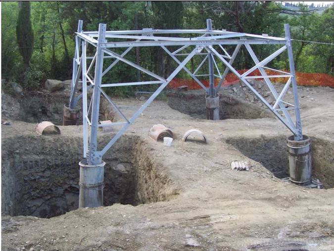
Figura 9 - Realizzazione di fondazioni superficiali tipo CR per un sostegno a traliccio. Nell'immagine si possono osservare le quattro buche, la base del sostegno collegata alla fondazione tramite i "monconi" ed i casseri utilizzati per i quattro "colonnini"
