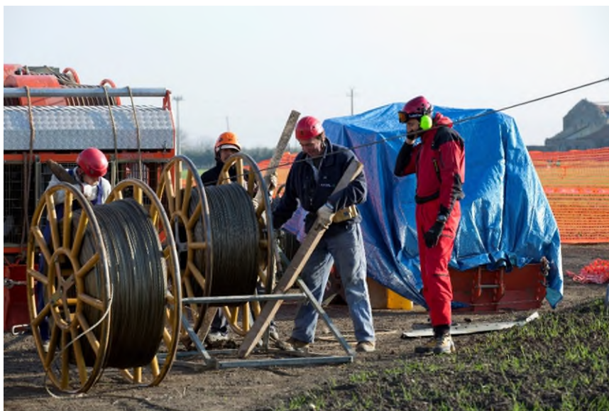
Figura 15 - Fasi di tesatura della linea elettrica
