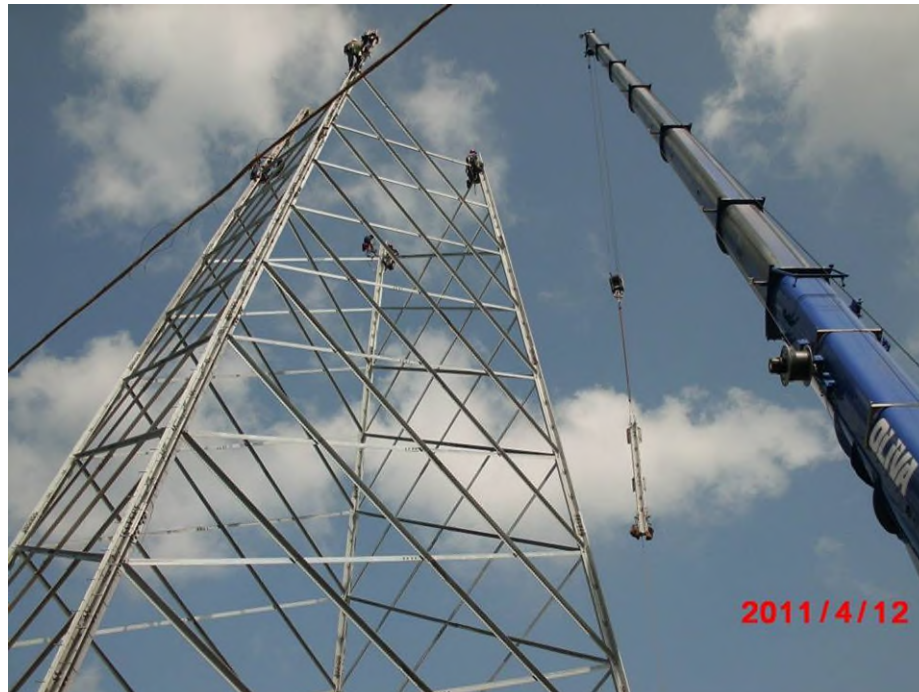
Figura 13 - Fasi di montaggio sostegno a traliccio
