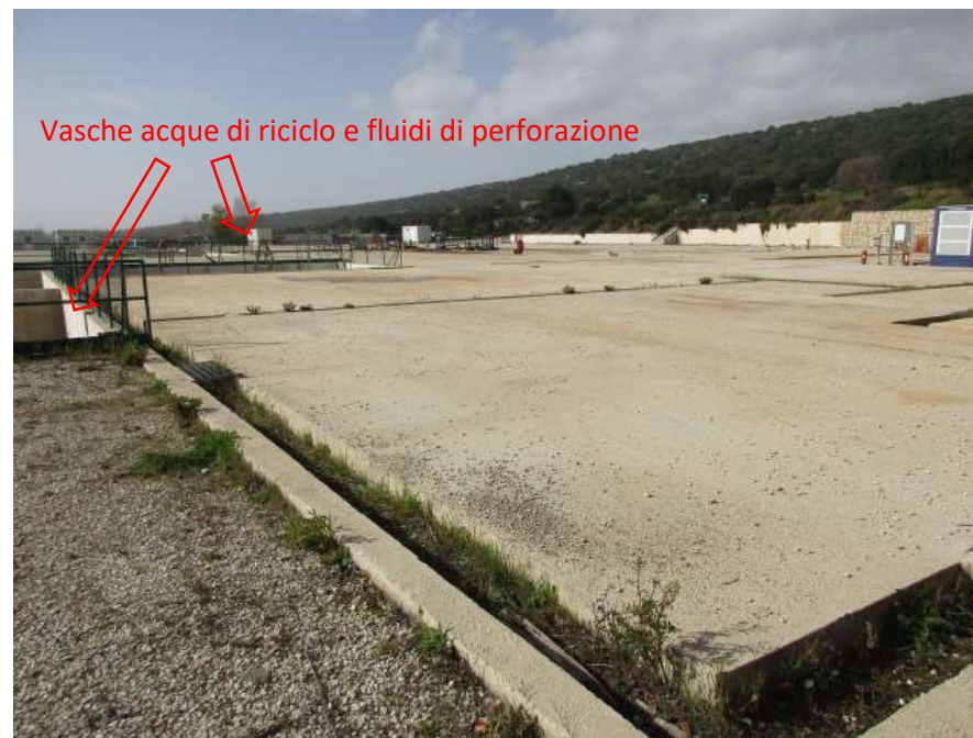
Cono 6 – Area pavimentata IRM 6 lato valle
