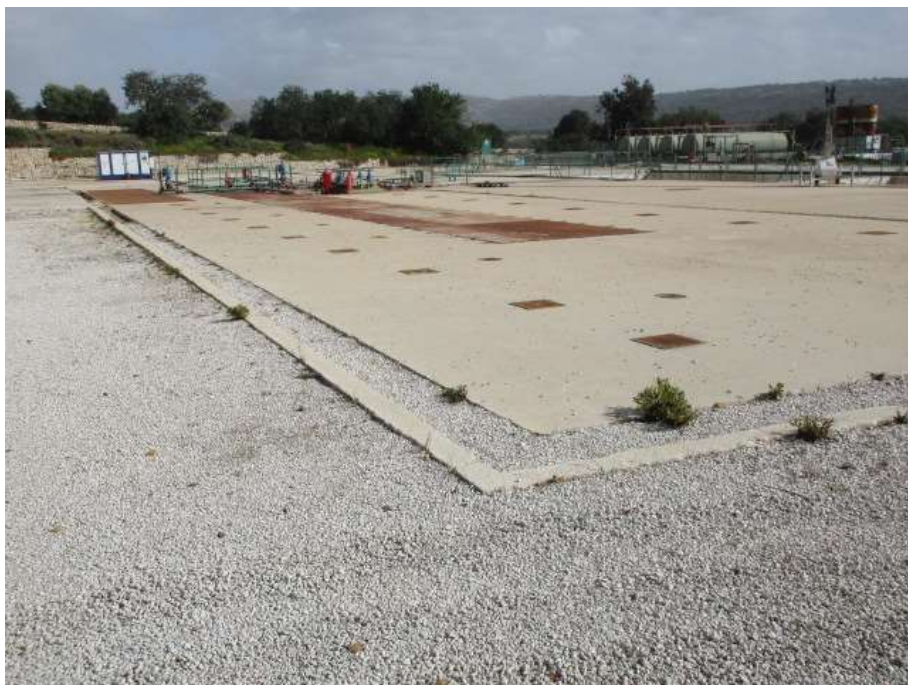
Cono 11 – Panoramica Area Pavimentata Pozzo IRM 6
