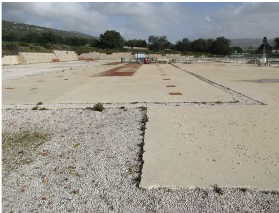
Cono 12 – Area Pavimentata Pozzo IRM 6 Vista da lato Ovest
