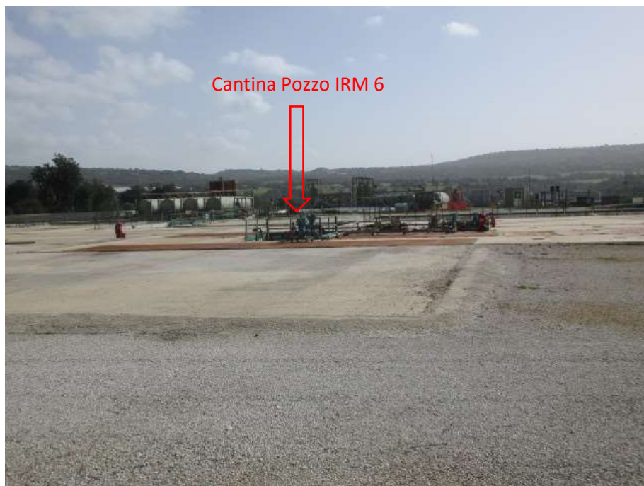
Cono 3 - Vista da lato NO area pavimentata
