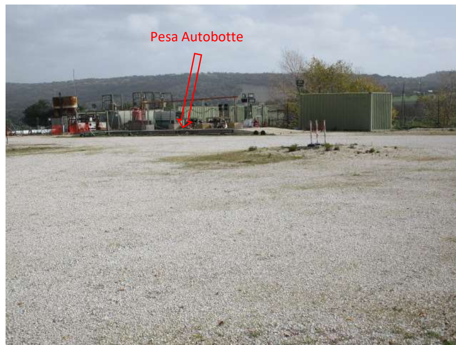
Cono 2 - Panoramica area pensilina di carico
