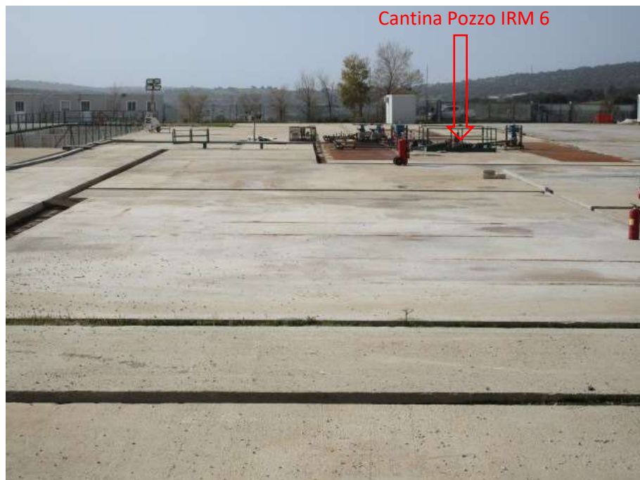
Cono 5 – Vista da lato NE area pavimentata
