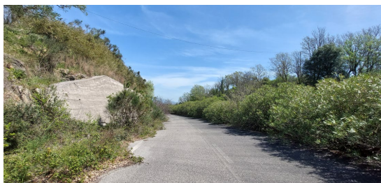
Figura 8: Trincea con muro in sinistra Lotto 4
