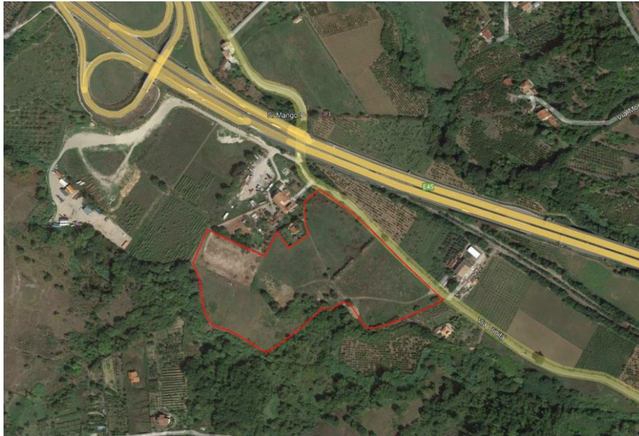
Figura 3-3. Area individuata per il posizionamento del cantiere base N°1
