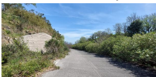
Figura 2-8: Trincea con muro in sinistra Lotto 4
