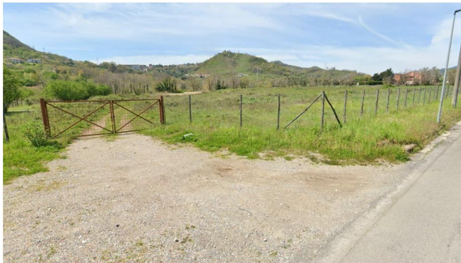
Figura 3-4. Ripresa fotografica accesso area cantiere base N°1
