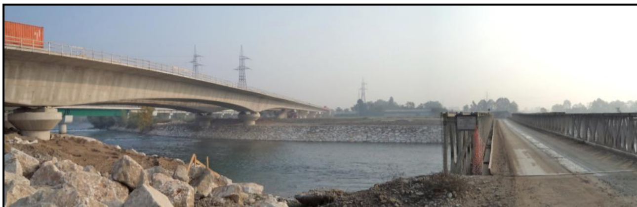
Figura 2.3b L'attraversamento del Fiume Adda del Cantiere delle Infrastrutture
