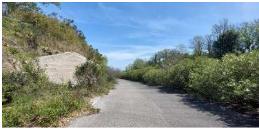
Figura 2-8: Trincea con muro in sinistra Lotto 4
