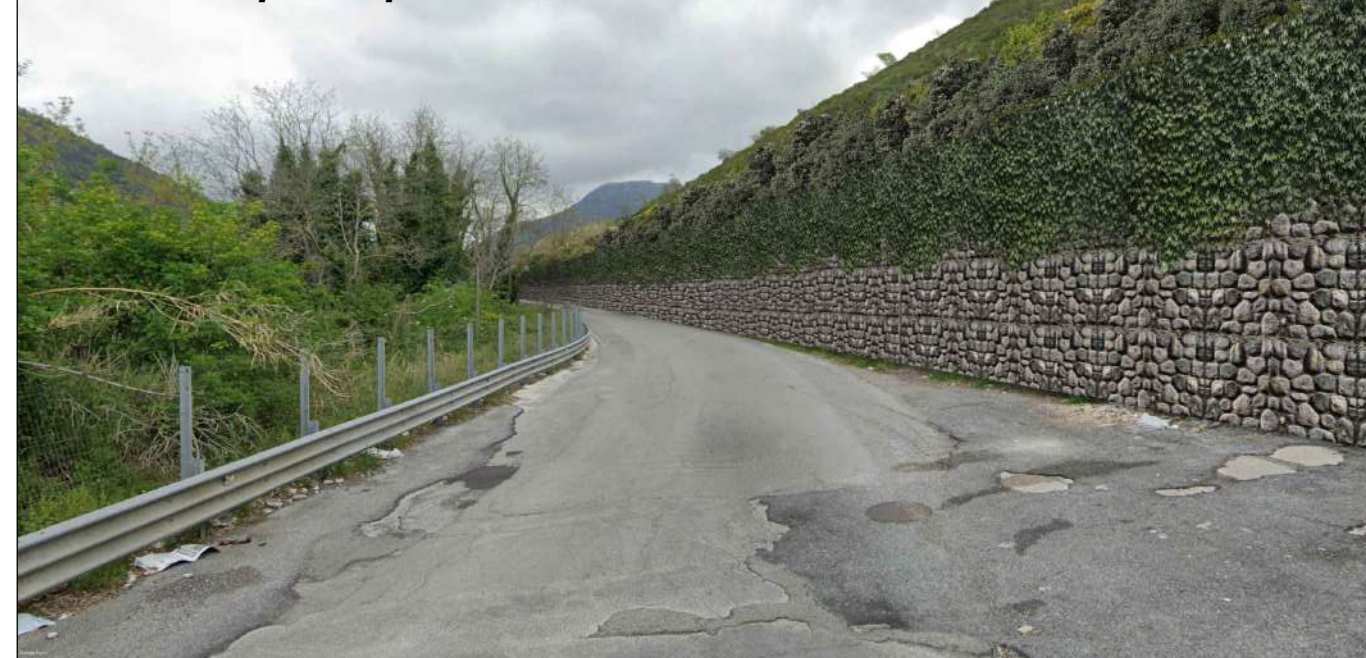
TRATTO 2 - post operam
