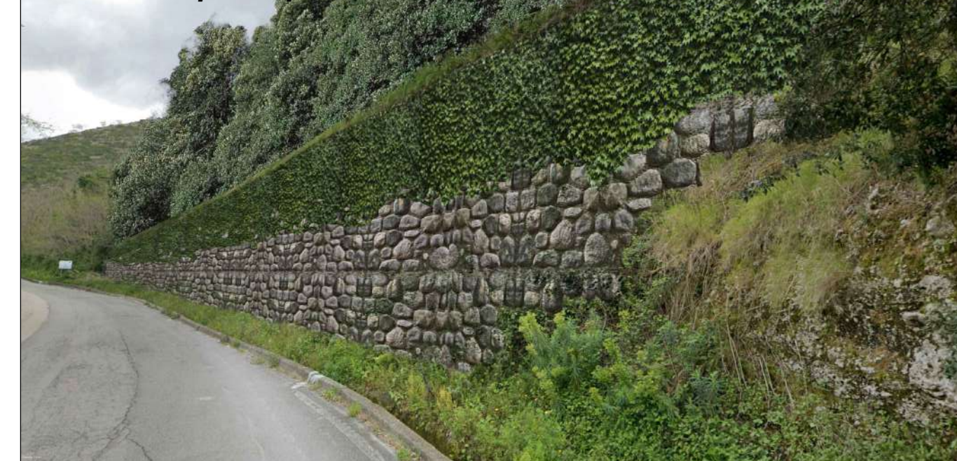
TRATTO 3 - post operam
