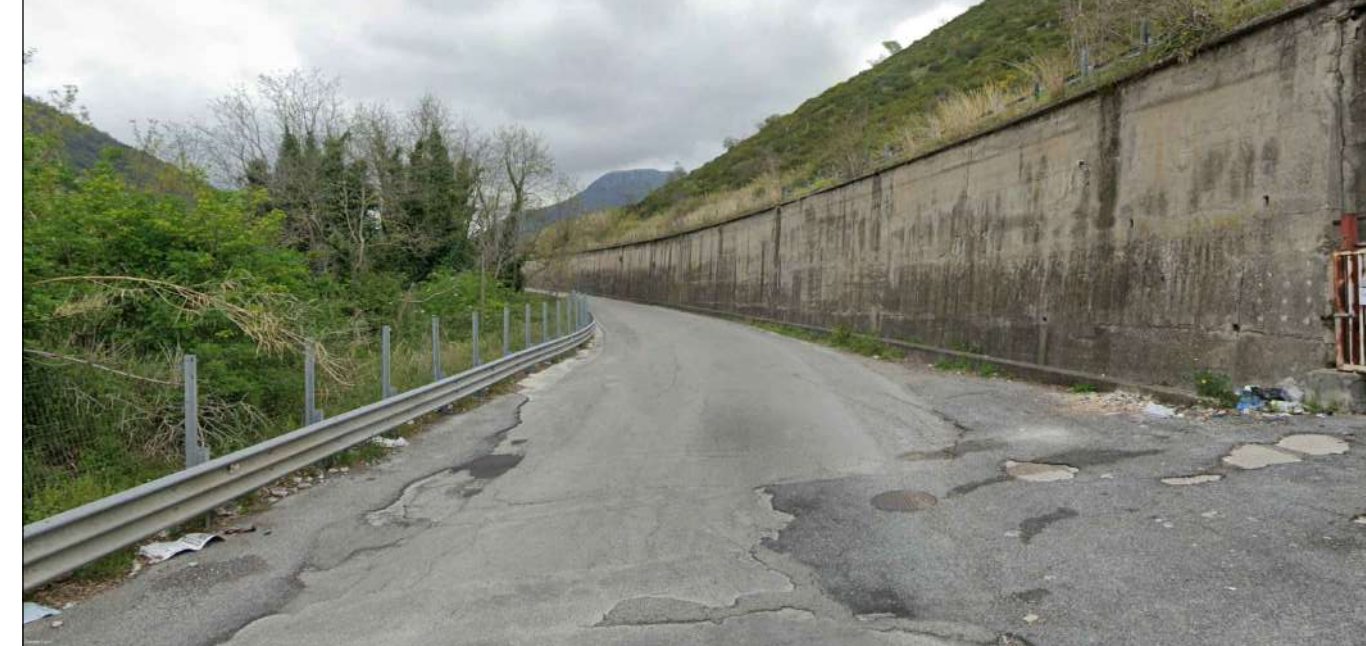
TRATTO 2 - stato attuale
