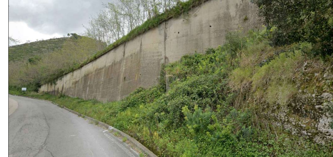
TRATTO 3 - stato attuale
