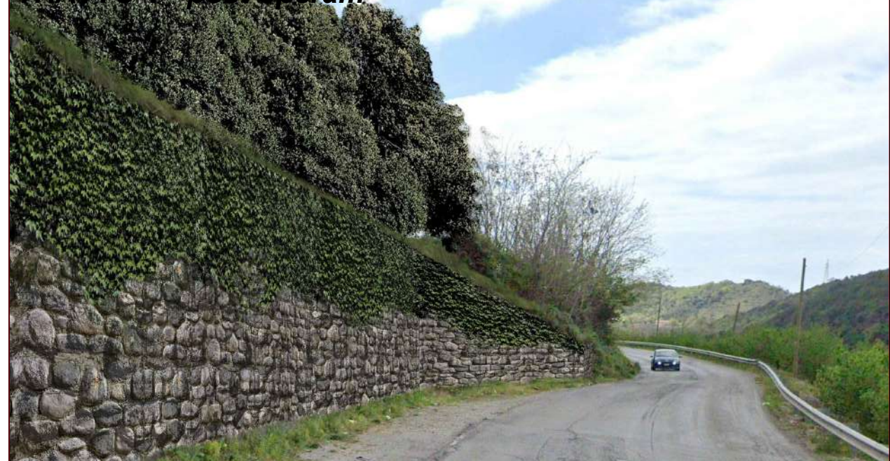
TRATTO 1 - post operam
