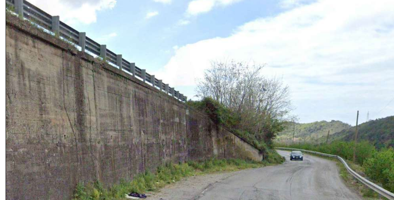
TRATTO 1 - stato attuale
