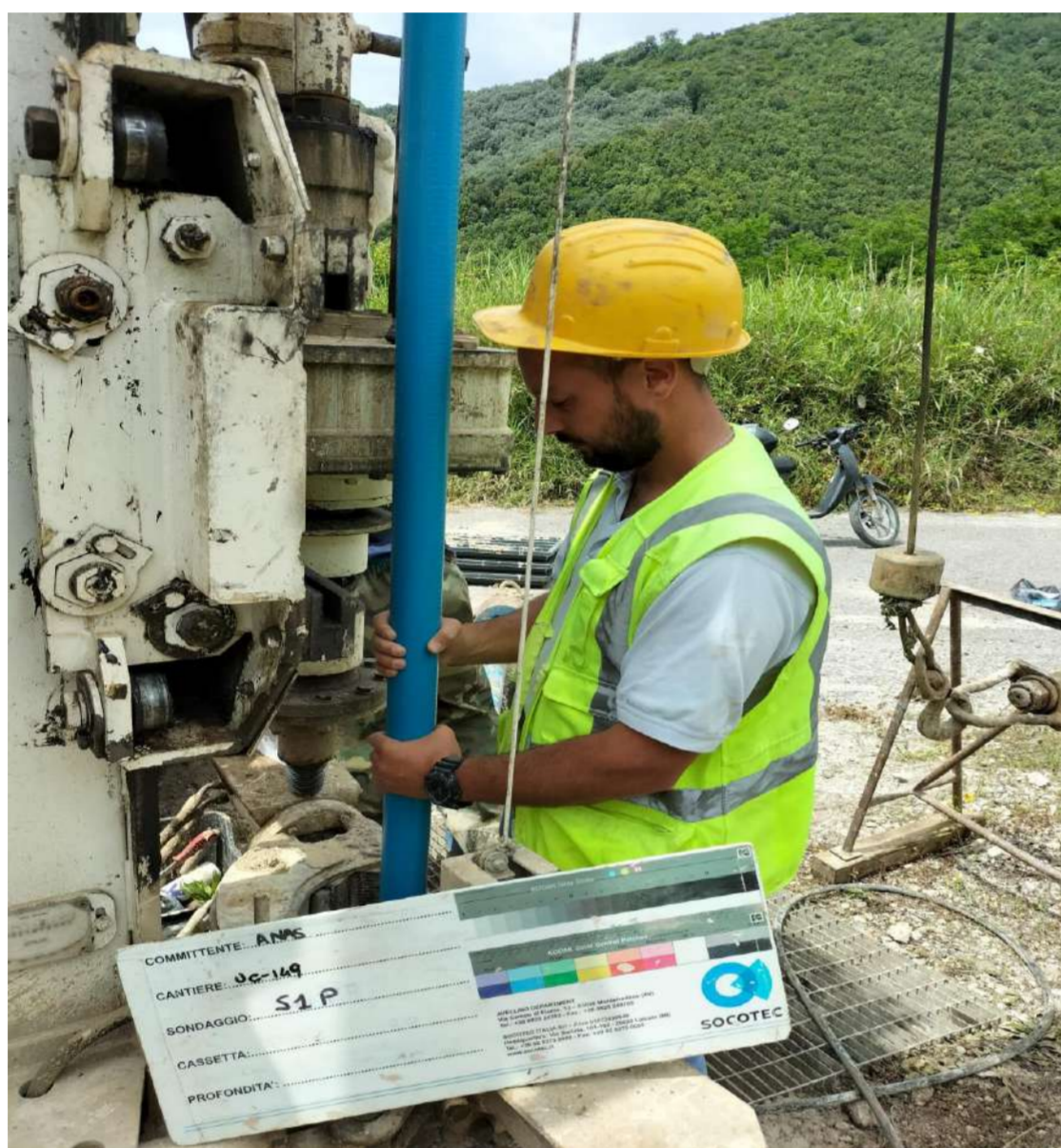
INSTALLAZIONE PIEZOMETRO
