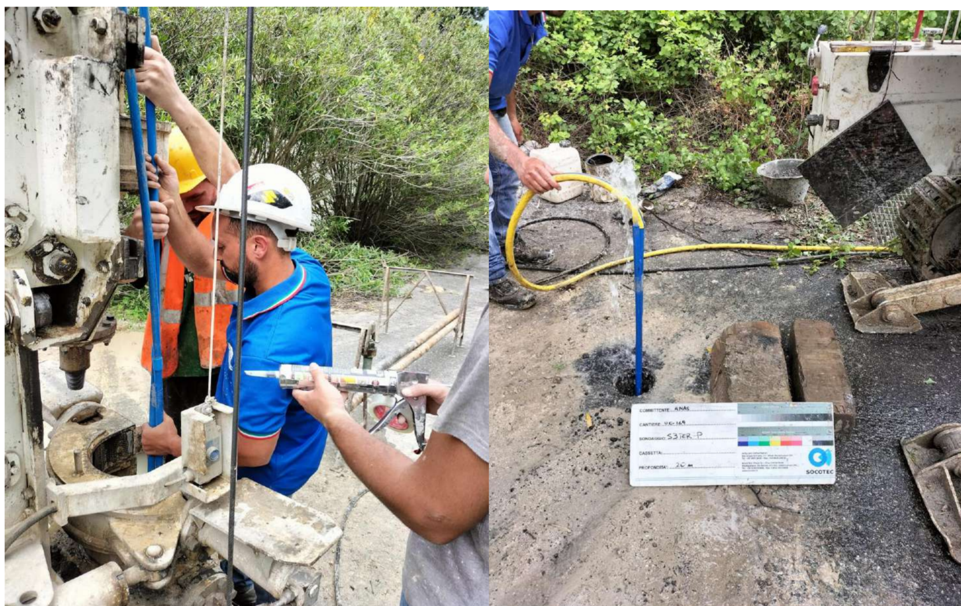
INSTALLAZIONE CELLA DI CASAGRANDE
