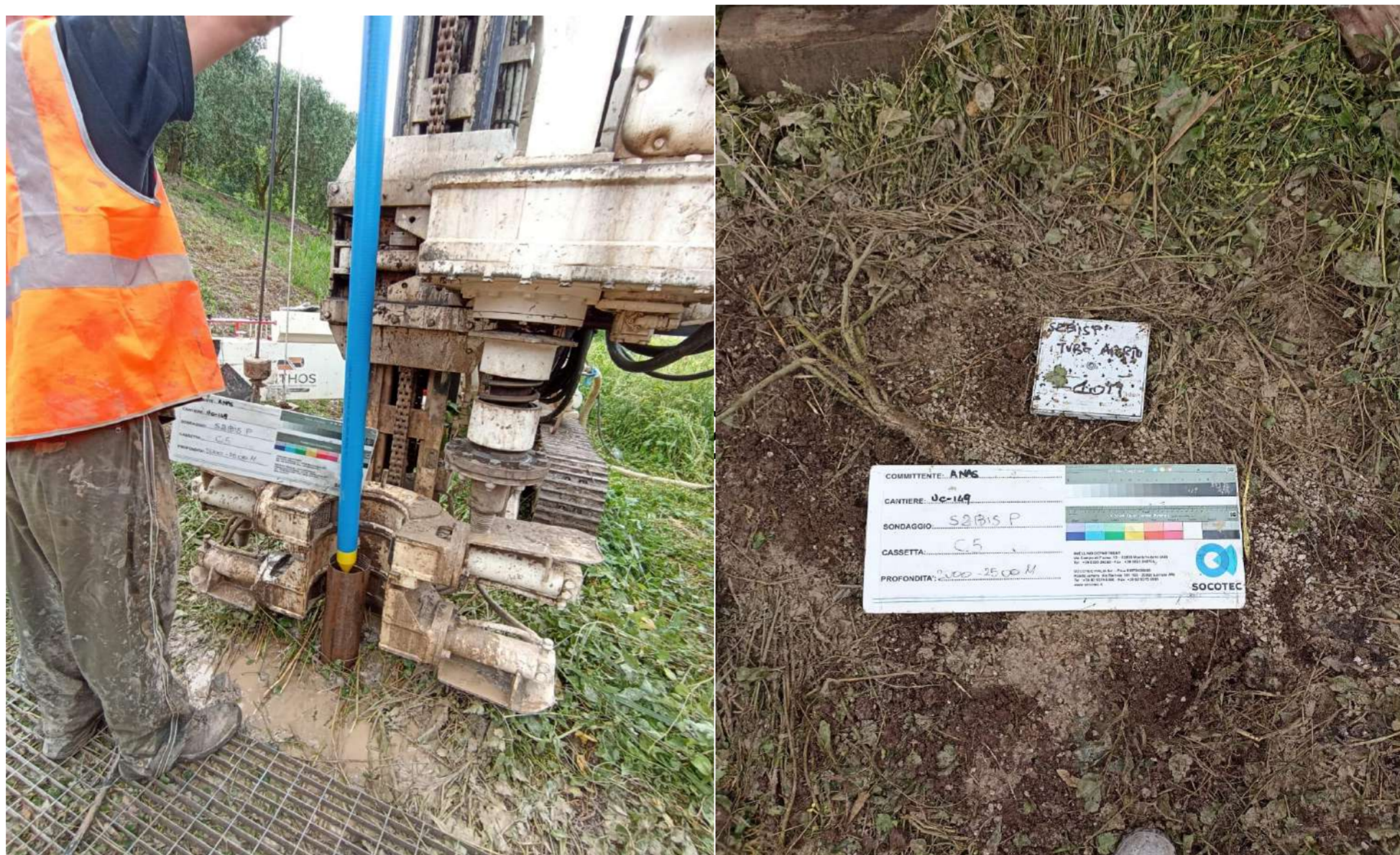
INSTALLAZIONE PIEZOMETRO A TUBO APERTO
