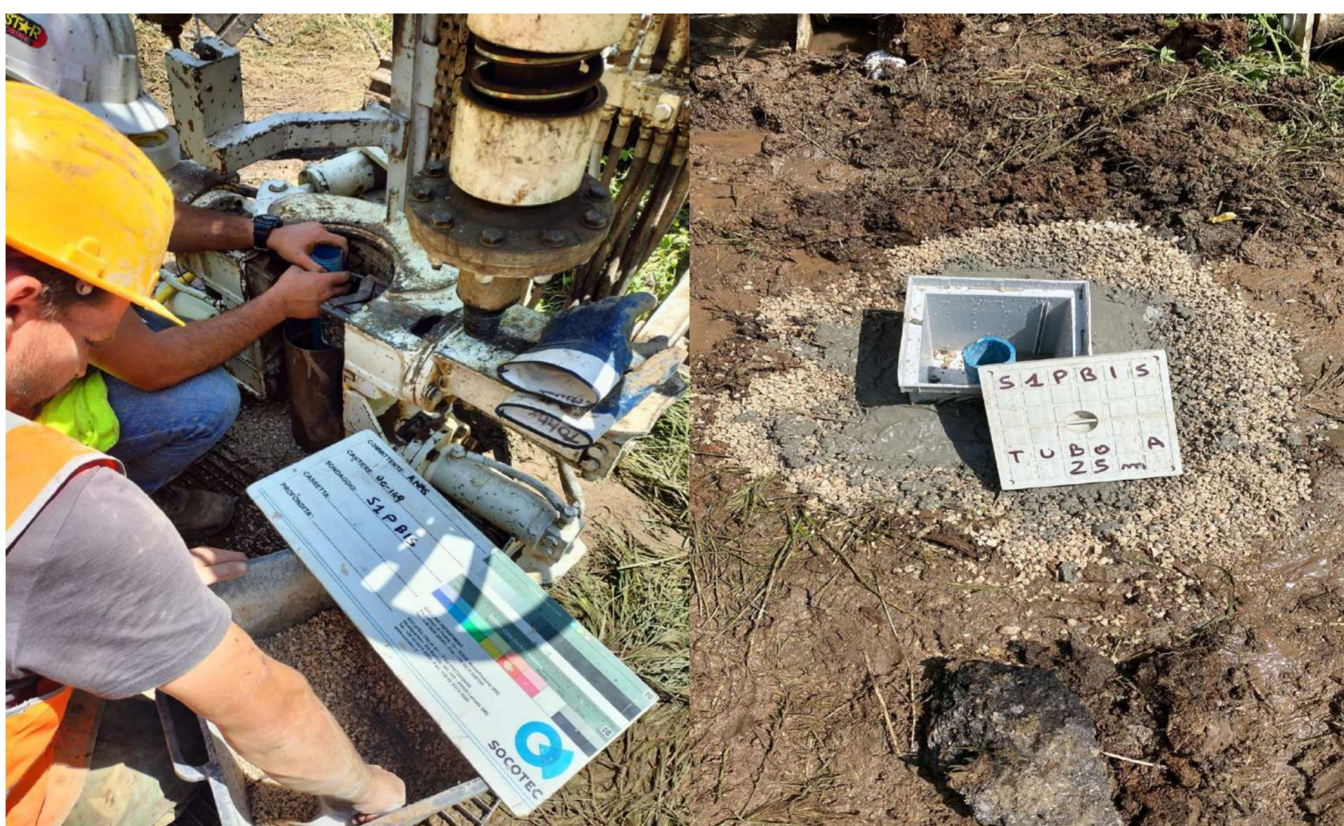
INSTALLAZIONE PIEZOMETRO A TUBO APERTO
