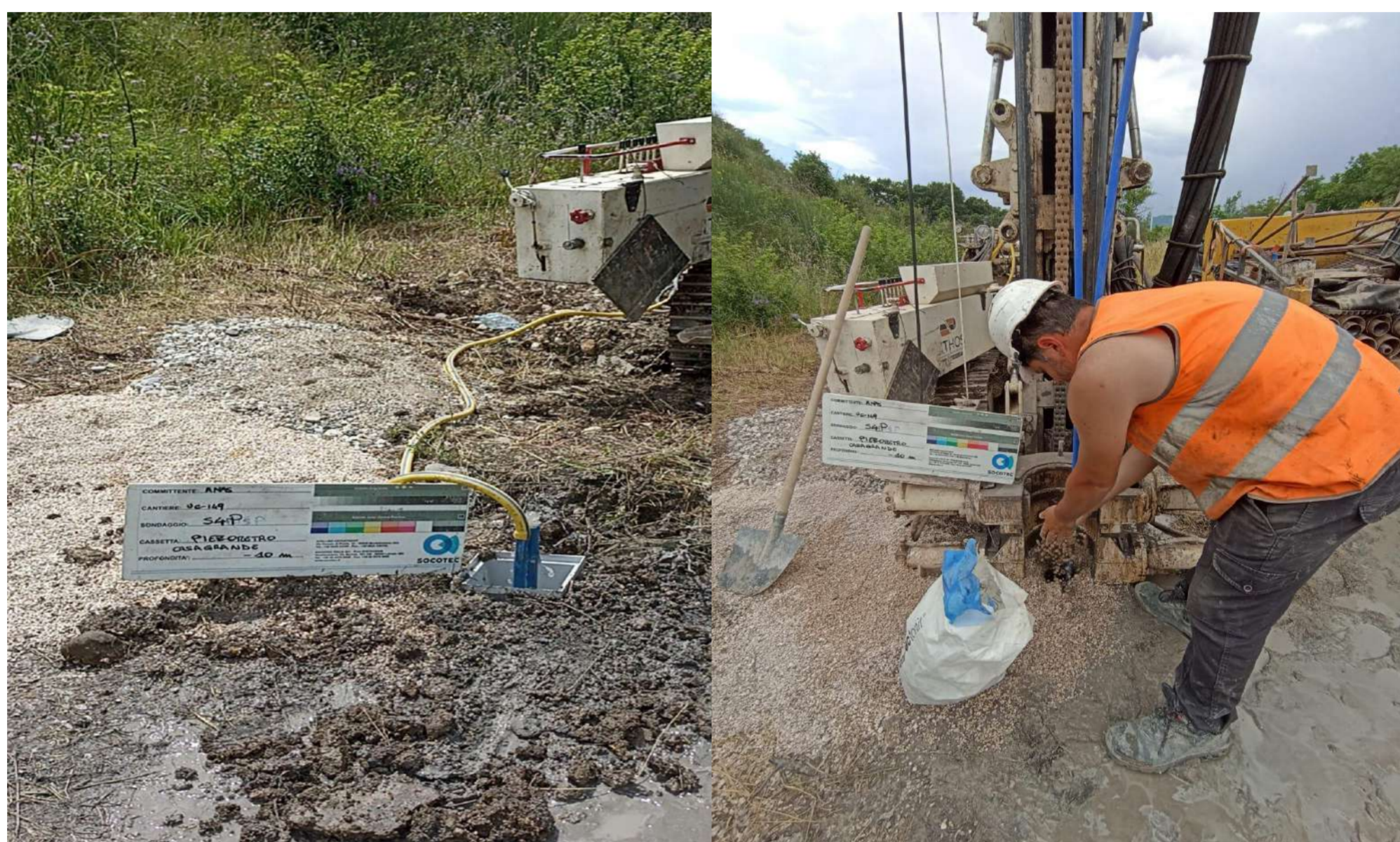
INSTALLAZIONE PIEZOMETRO CASAGRANDE E SPURGO PIEZOMETRO
