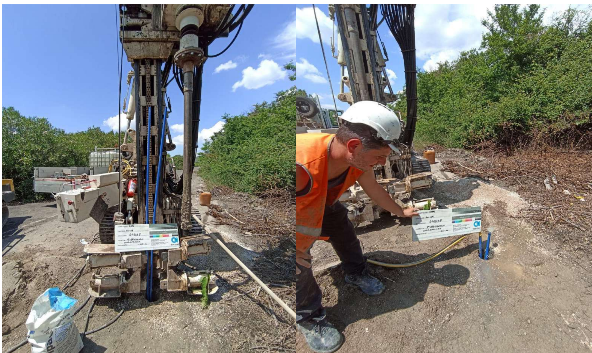
INSTALLAZIONE PIEZOMETRO CASAGRANDE E SPURGO PIEZOMETRO
