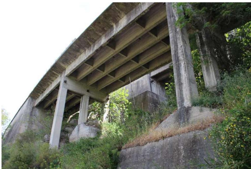
Figura 2.1: Vista Semi-Viadotto T02-VI02
