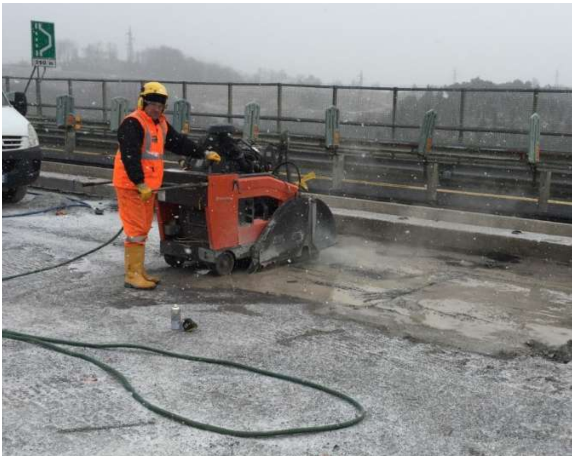
Foto 34.a. e "b". Taglio a diamante delle solette in calcestruzzo armato: tagliamuro (sopra) e tagliasuolo (sotto).
