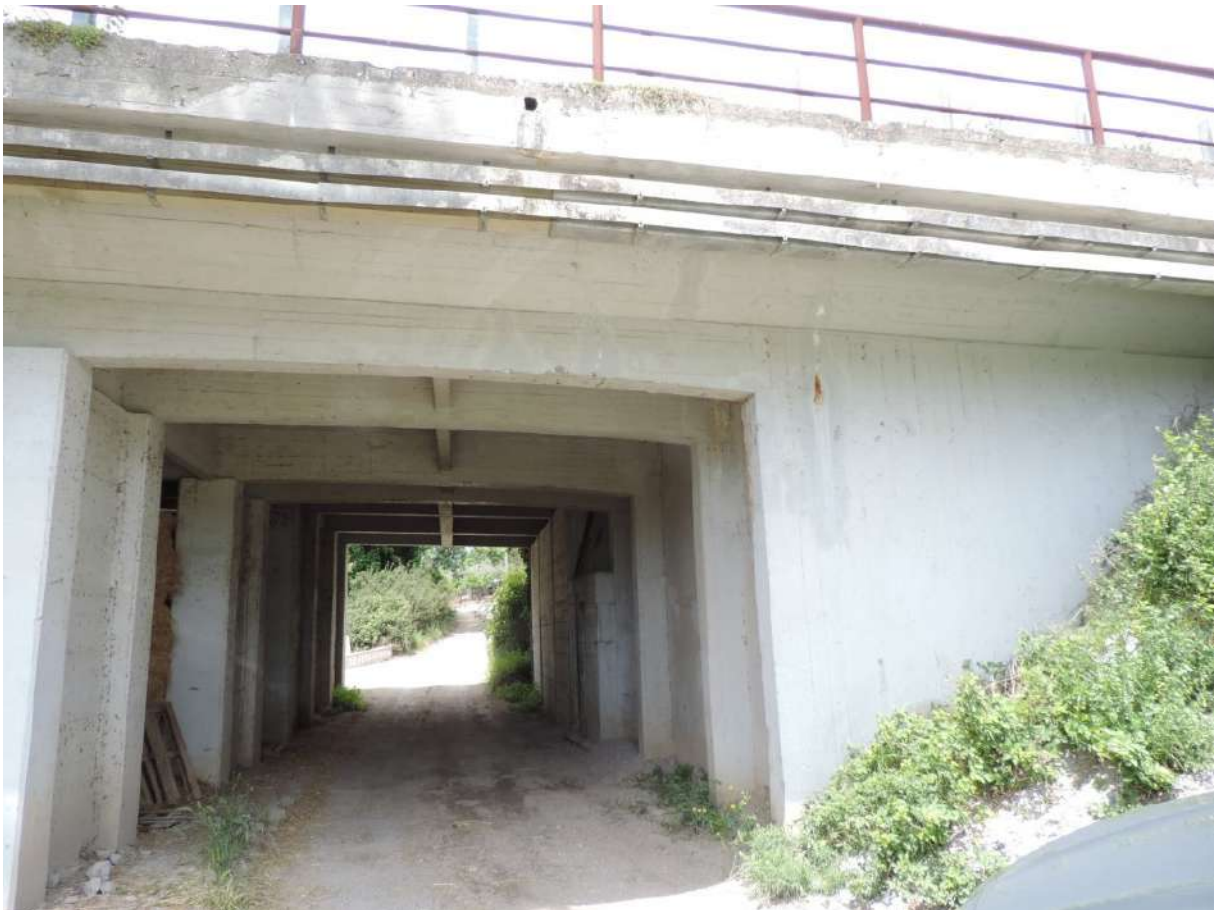
Foto 24.a e "b" Sottopassaggio per la strada locale.
