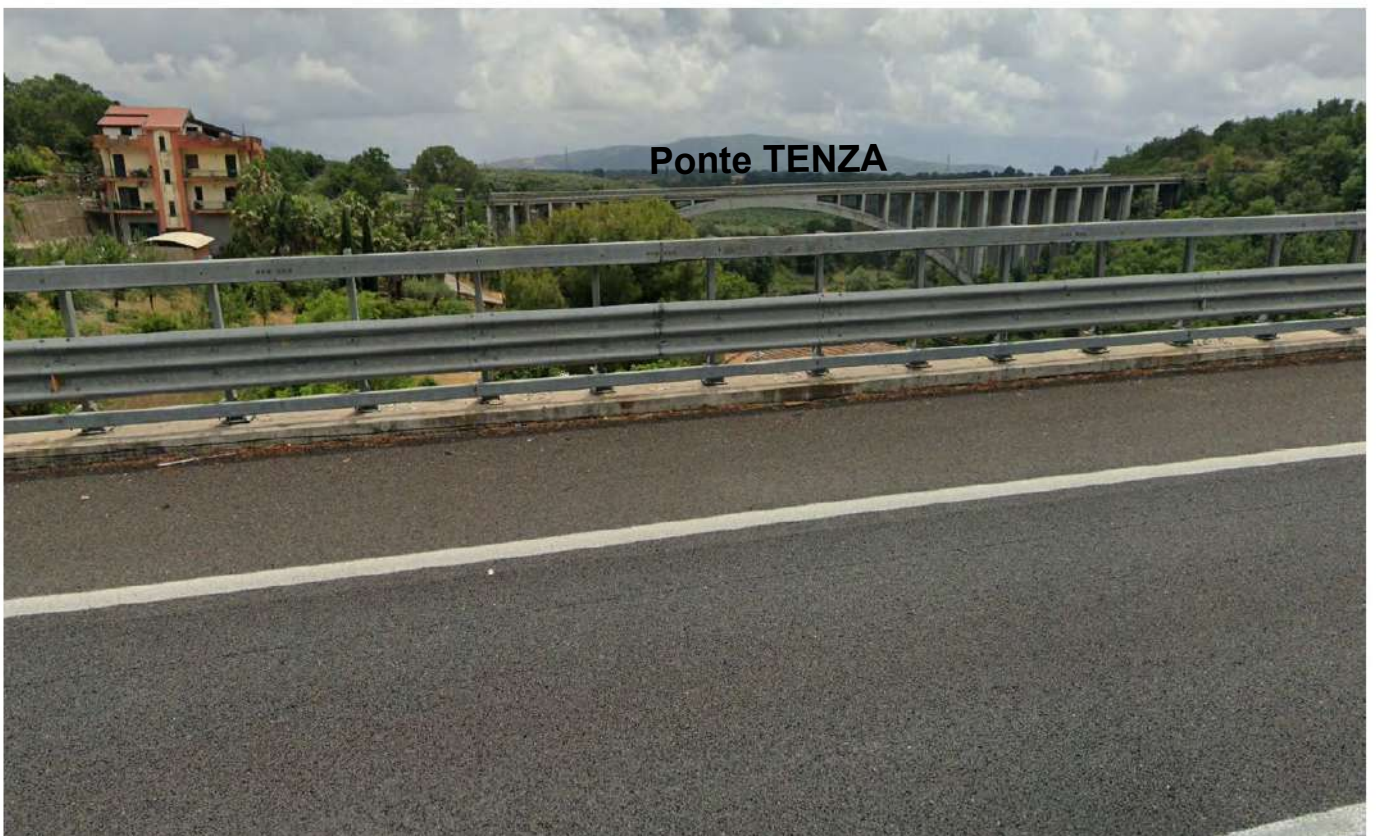
Foto 19.a e "b" Vista del ponte TENZA dalla strada locale e dal tratto i esercizio della nuova autostrada SA-RC (all'altezza del km 42+800).
