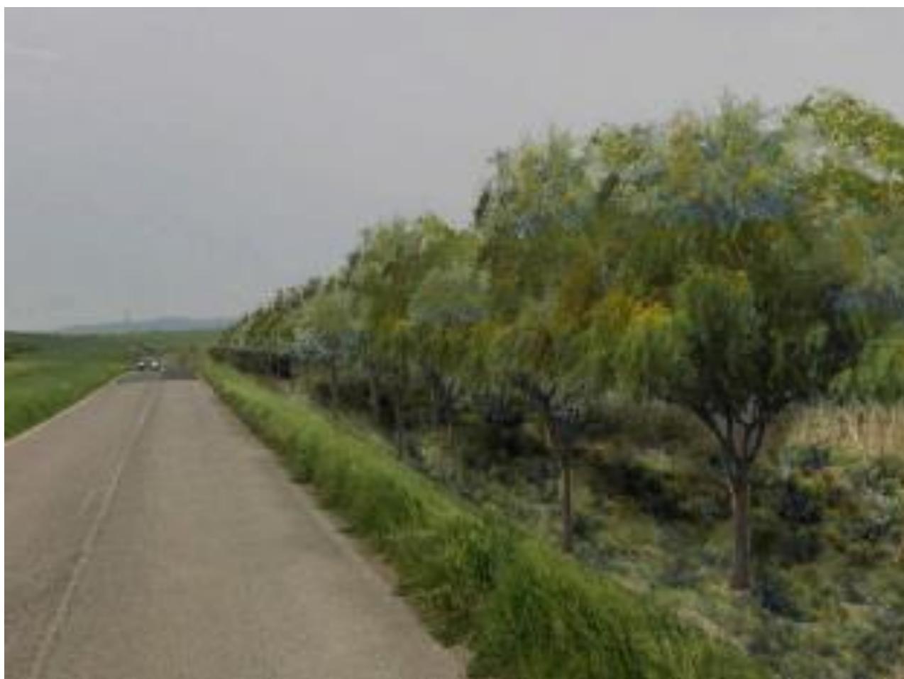
Figura 55 tipologia delle opere di mitigazione visiva realizzata con filare di Acacia
