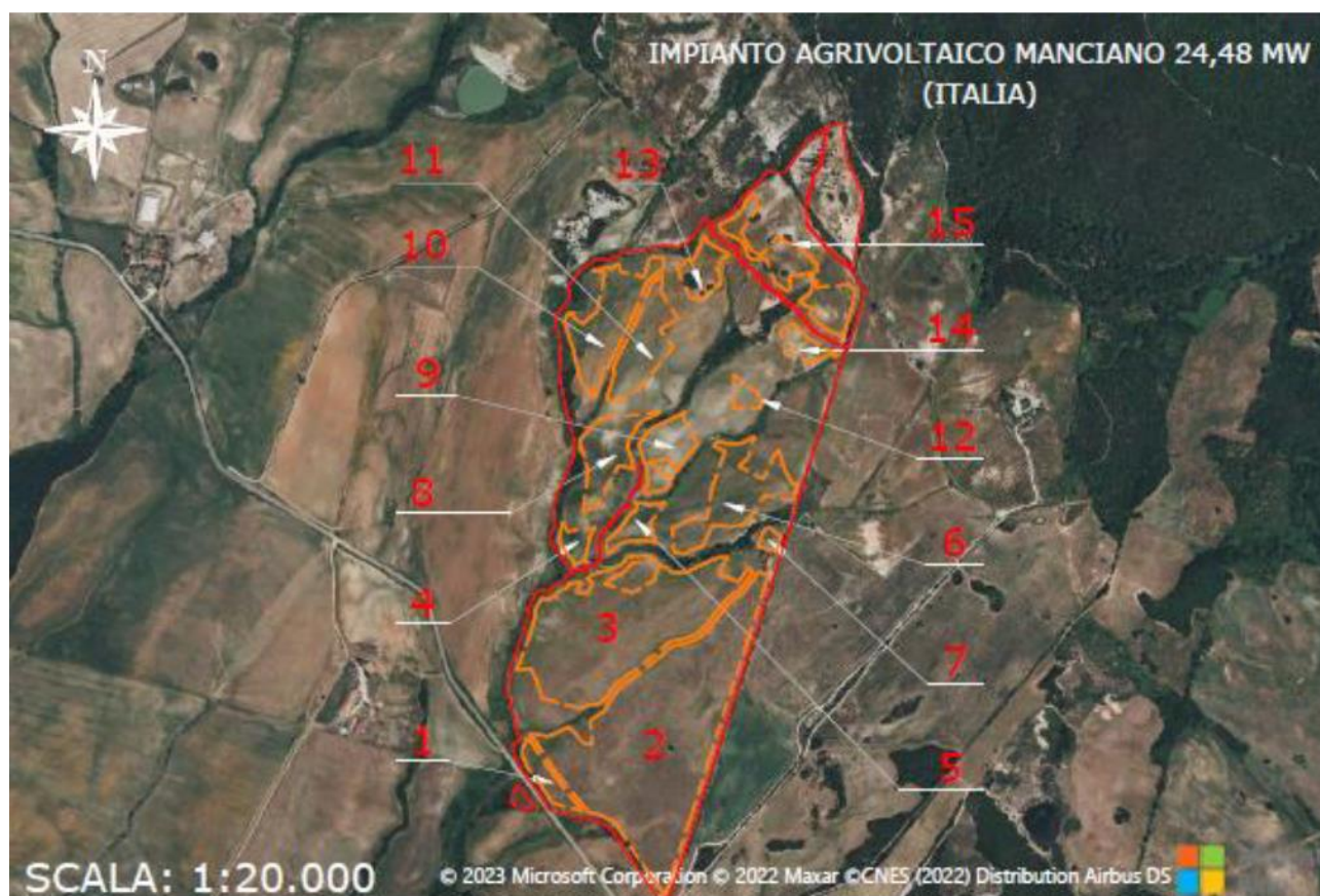
Fig. 2 – Ortofoto con ubicazione dell'area di impianto
