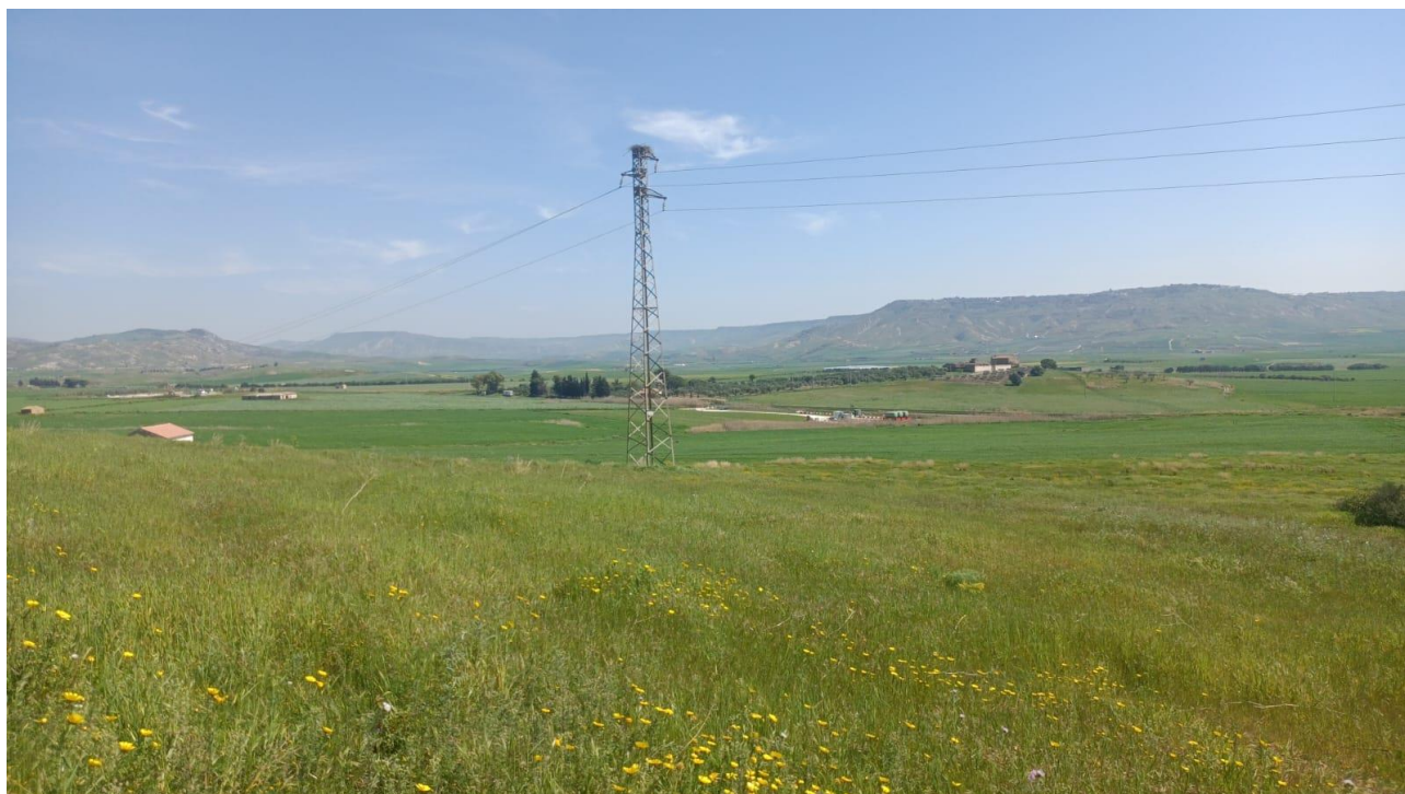
Figura 8 – Fotografia della linea aerea che attraversa l'impianto
