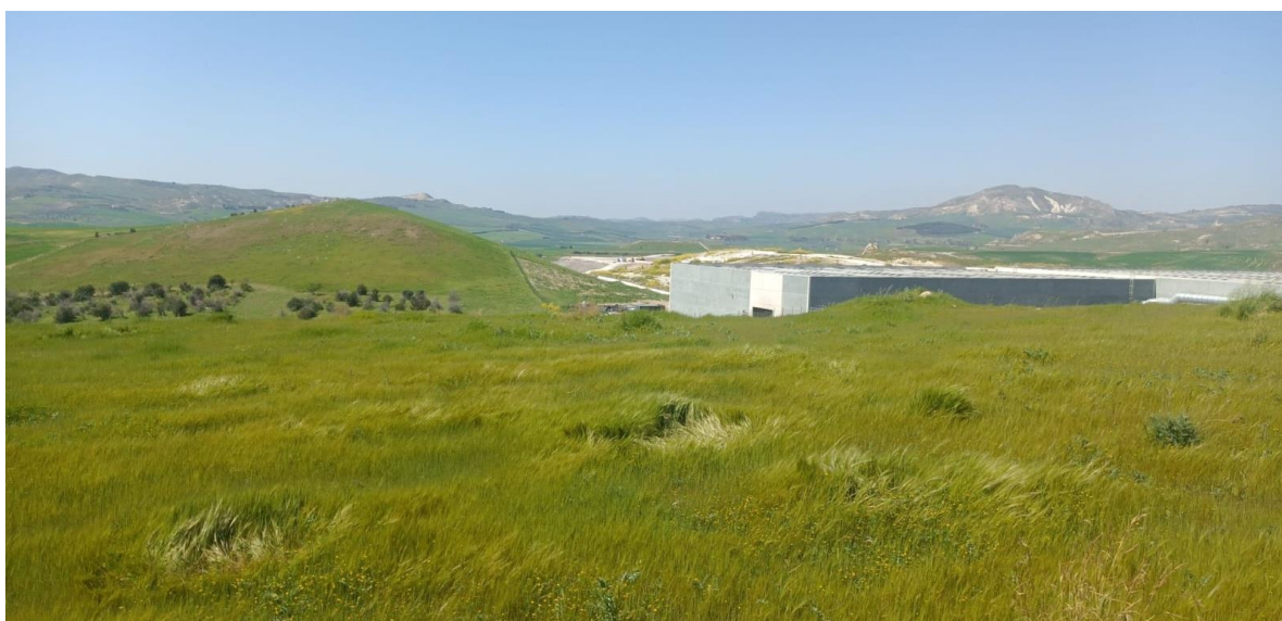
Figura 6 – Fotografia del sito interessato dall'impianto.
