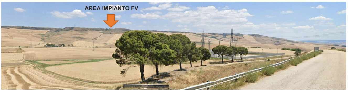
Panoramica dal Punto 3 – post operam
