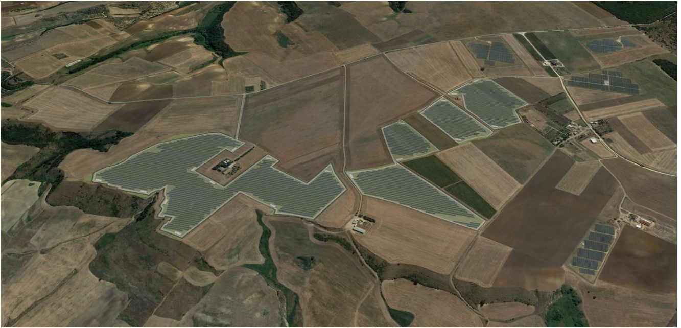
Panoramica B – Vista Ovest
