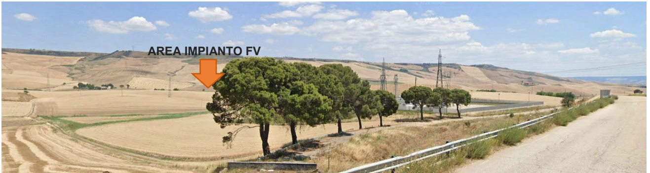
Figura 3-31: Vista da P3 (Tratturello Tolve-Gravina) verso l'area di impianto
