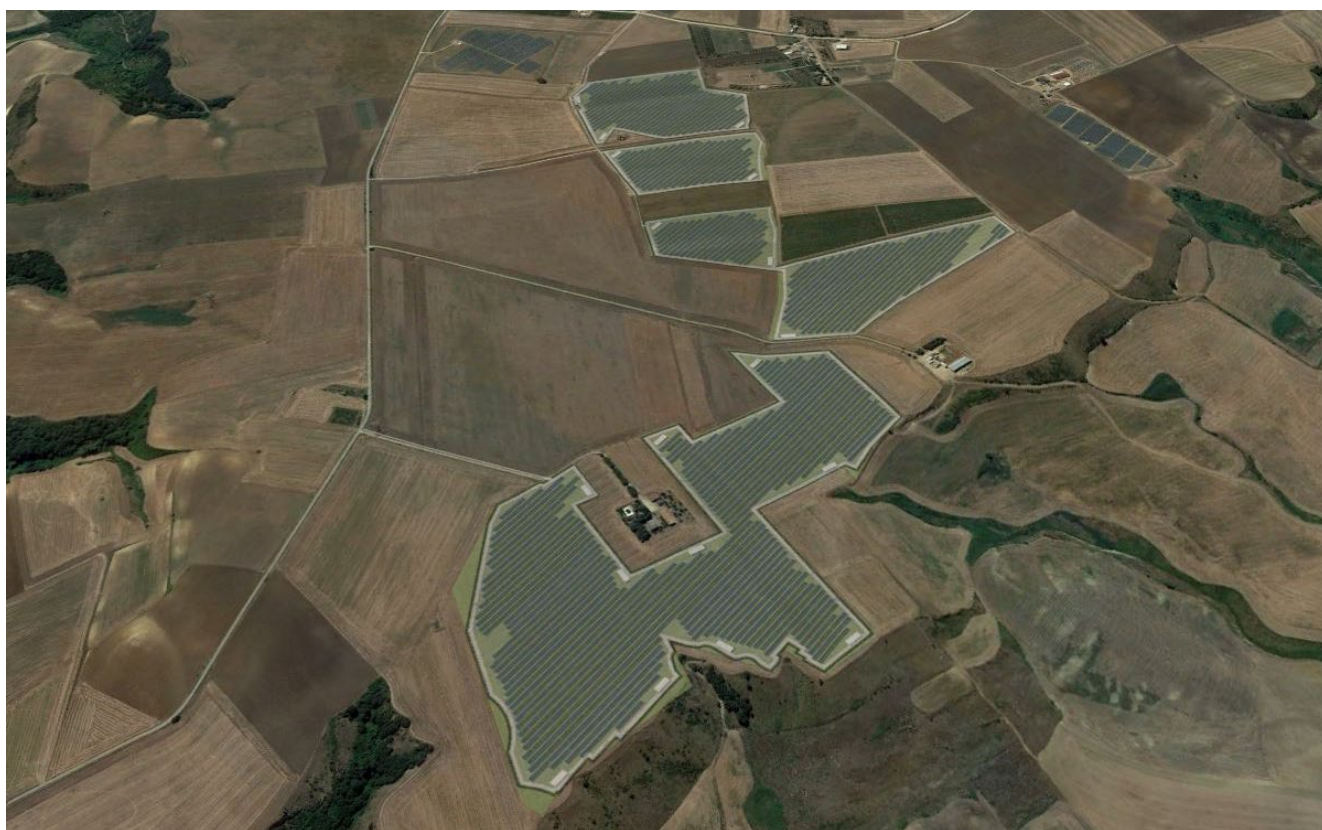
Vista A – Lato Nord-Ovest
