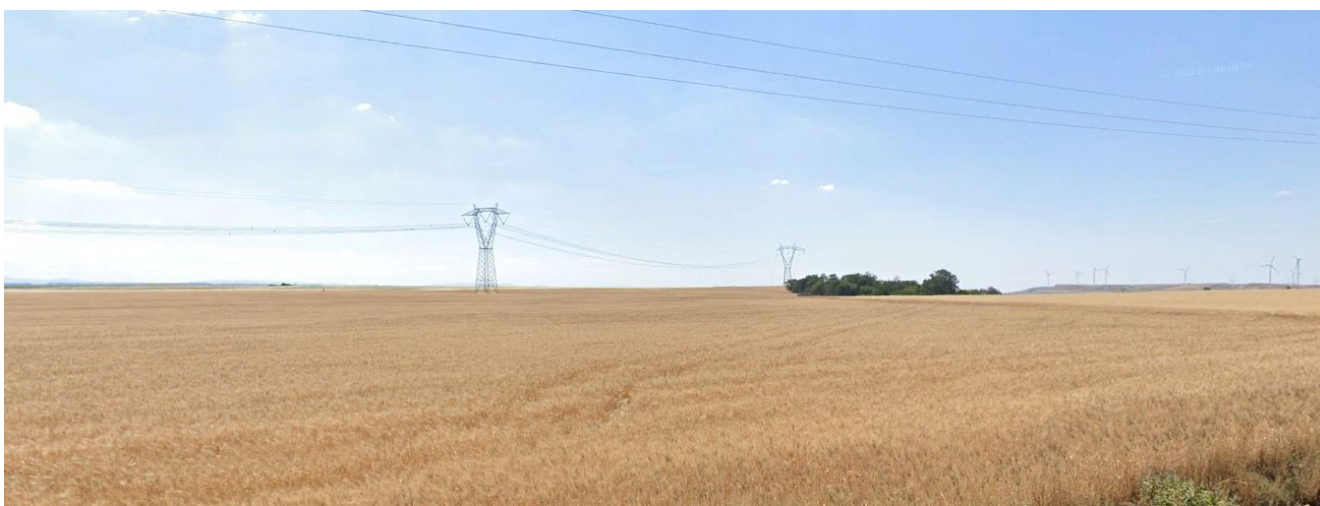
Figura 3-19: Vista della Sottostazione Utente
