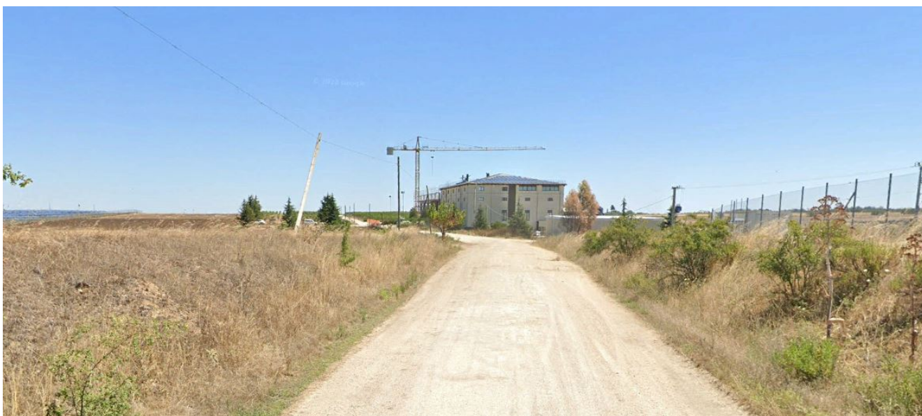
Figura 3-8: Contrada S.Domenico sud dell'impianto
