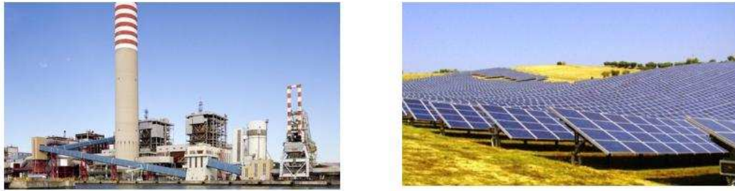
Figura 15 Confronto tra Centrale termica e Campo agrivoltaico
