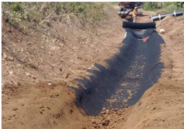
Figura 27 - Esempio canale di terra
