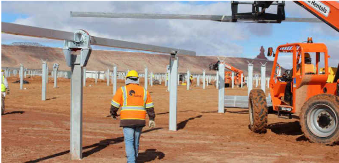
Figura 31 – Posizionamento-tipo dei profili metallici montati in sito
