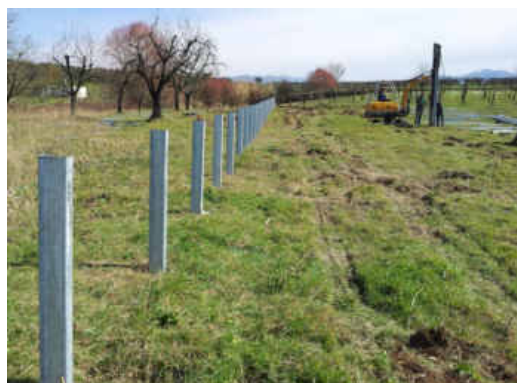
Figura 29 – Installazione dei montanti verticali
