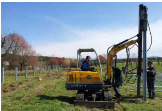
Figura 29 – Installazione dei montanti verticali
