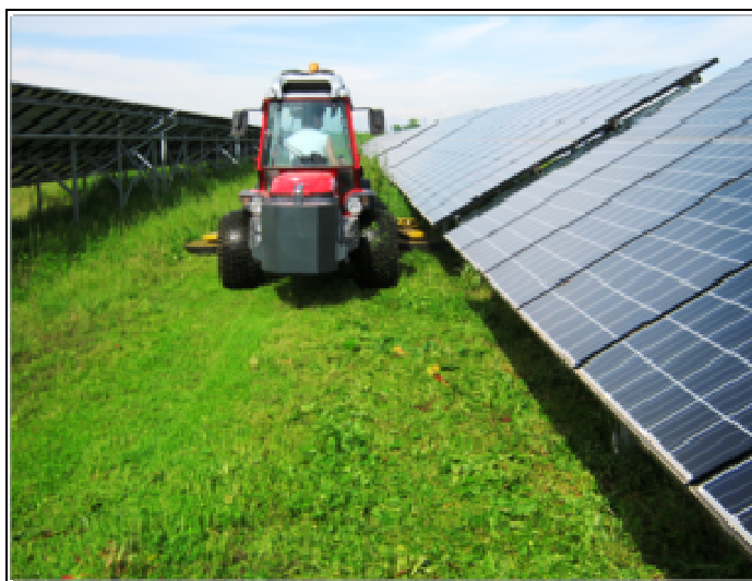
Figura 42 – Impianto con coltivazione tra i tracker
