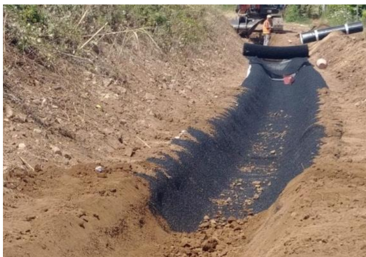
Figura 27 - Esempio canale di terra
