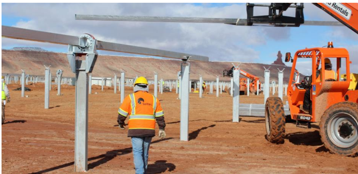
Figura 31 – Posizionamento-tipo dei profili metallici montati in sito
