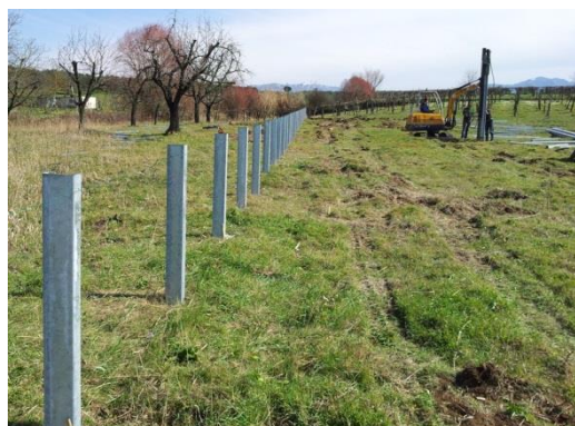
Figura 29 – Installazione dei montanti verticali
