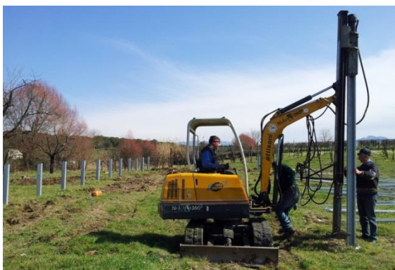
Figura 29 – Installazione dei montanti verticali
