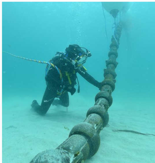
Figura 6.12 Esempio di metodo di posa con gusci di protezione [Fonte: Farinia Group]
