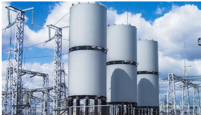
Figura 6.21 Esempio di reattori di shunt isolati in aria [Fonte: Trench Group]
