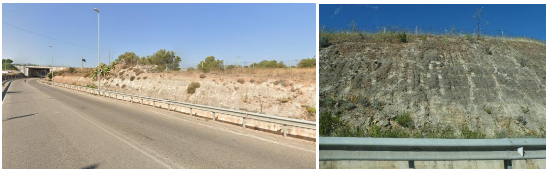
Figura 5.11 Affioramenti sustrato presso lo svincolo Monopoli Nord
