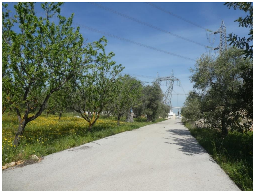
Figura 5.21 Centrale Elettrica Terna di Palo del Colle
