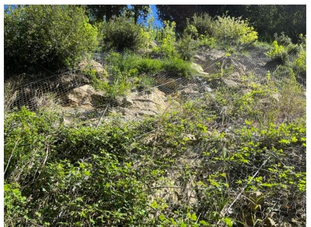
Intervento di consolidamento del versante in roccia (arenaria) delle *"FAA<sub>3</sub>"* – *Argille Azzurre* nei pressi del km 1+200.
