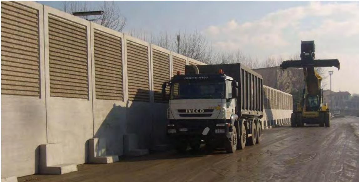
Figura 100 immagine di esempio di installazione di una barriera mobile
