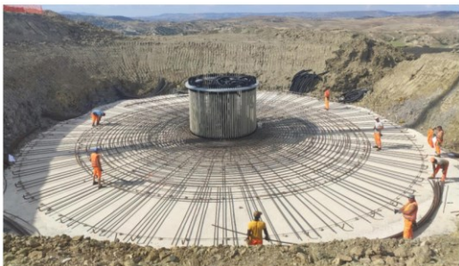
Figura 4. Immagine tipo posa anchor cages
