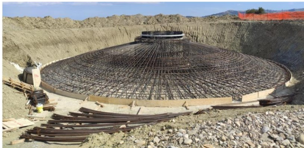
Figura 5. immagine tipo armature plinto
