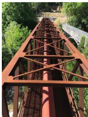
Figura 12 Esempio attraversamento in acciaio
