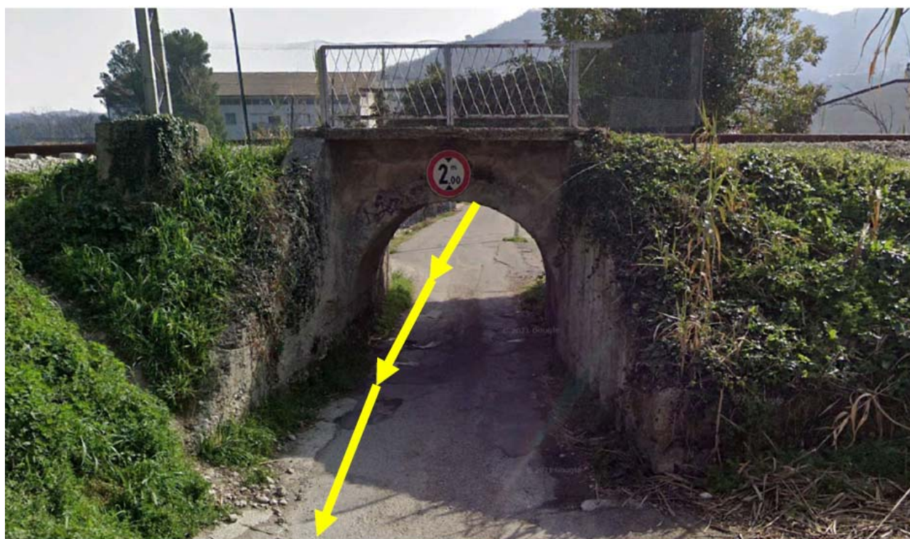
Figura 13 Sottopasso ferroviario esistente
