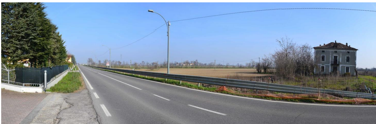
Fotografia 27 – Vista panoramica in direzione nord-est verso l'area di progetto dai pressi della loc. Valgrilla lungo la SS 211.
