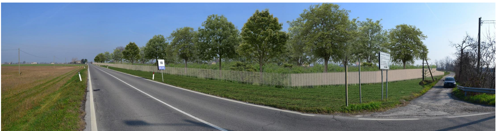
Figura 40 - Stato di progetto. Vista panoramica in direzione nord-est verso l'area di progetto dal suo margine sud-occidentale lungo la SS 211. L'immagine mostra lo stato dei luoghi al termine della realizzazione degli apparati tecnologici con le opere di inserimento ambientale-paesaggistico.
