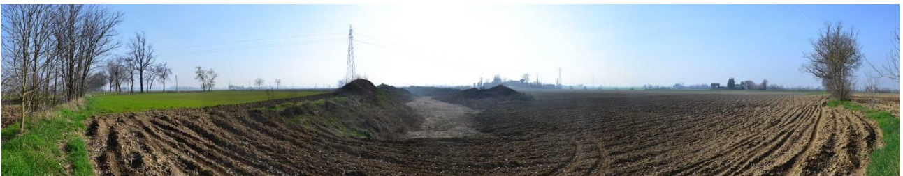
Figura 2.2.6 – Vista panoramica in direzione sud-ovest del settore nord-orientale dell'area di progetto dai pressi del margine nord-orientale della stessa.
