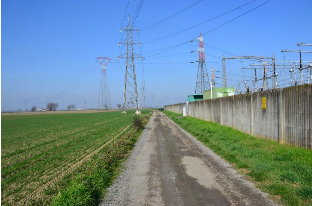
Fotografia 52 – Vista in direzione nord del percorso che costeggia la stazione elettrica di Castelnuovo Scrivia.
