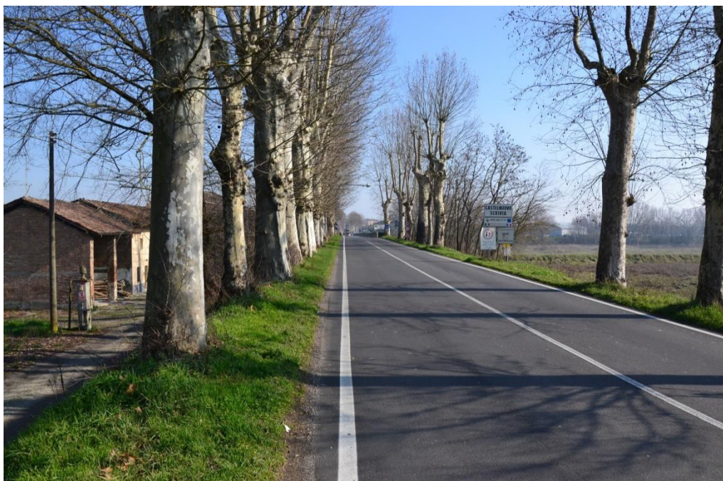
Fotografia 45 – Vista in direzione est della SP 85 all'imbocco del ponte di attraversamento del fiume Scrivia.
