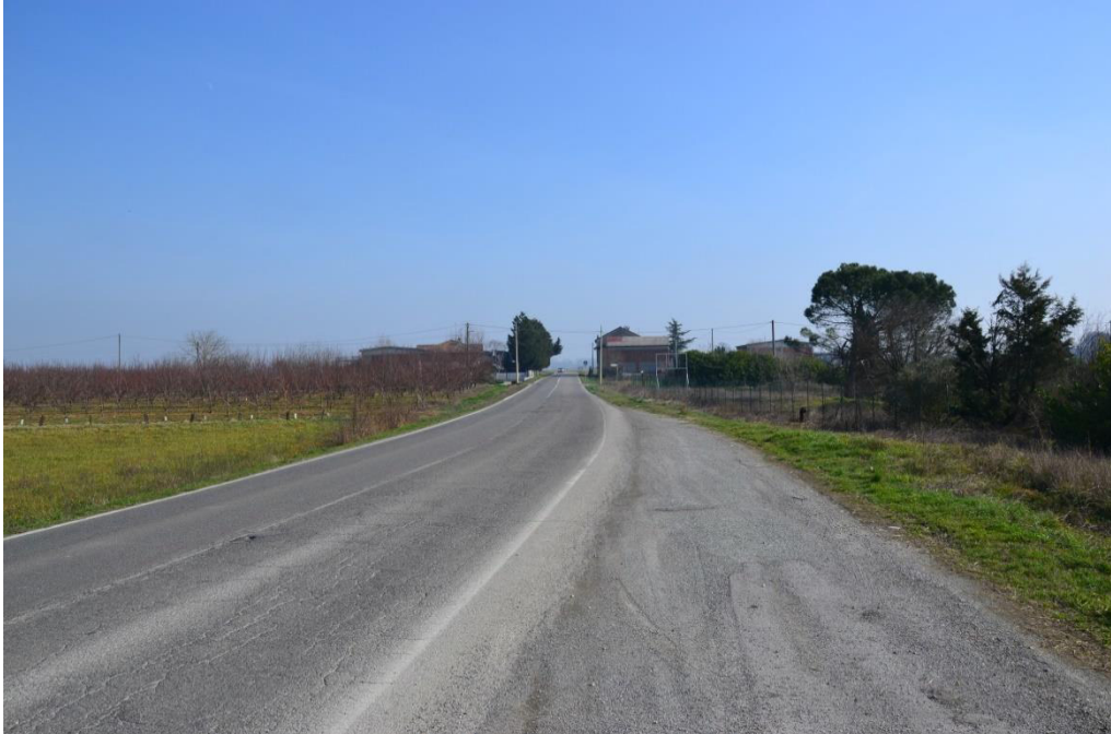
Fotografia 42 – Vista in direzione est della SP 85 nei pressi della località Cascina Colombina.
