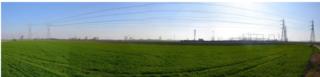
Fotografia 54 – Vista panoramica in direzione sud verso l'area individuata per la realizzazione della sottostazione.
