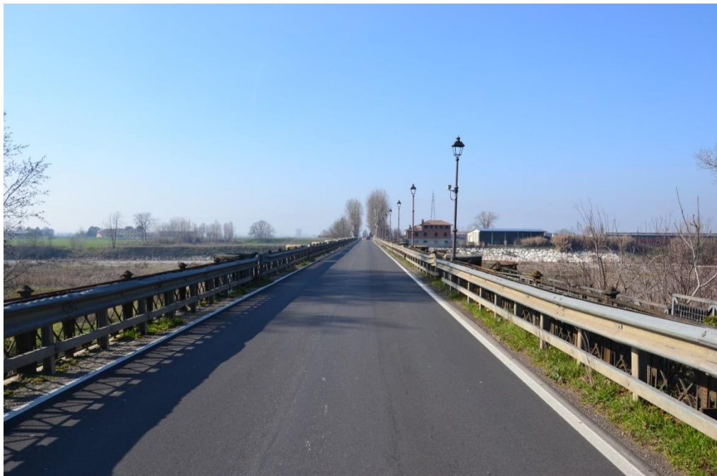
Fotografia 46 – Vista in direzione nord-ovest della SP 85 nel tratto di attraversamento del fiume Scrivia.
