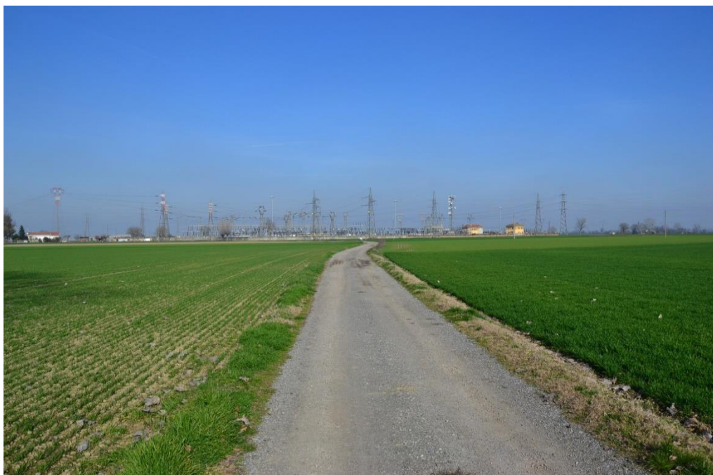
Fotografia 51 – Vista in direzione nord-est del percorso che conduce alla stazione elettrica di Castelnuovo Scrivia.
