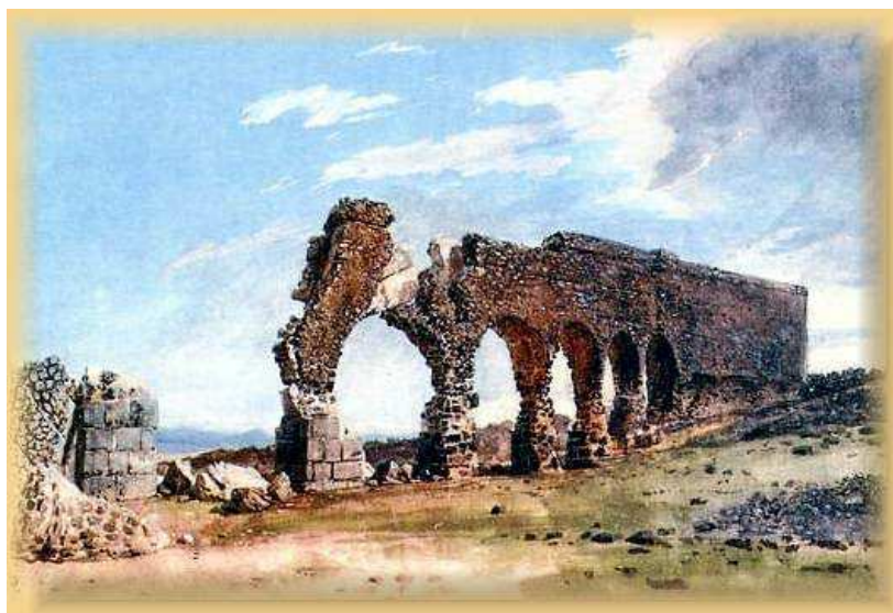
Fig. 7-9 Resti dell'acquedotto forse in contrada Valcorrente in un acquerello di Jean Houel.
