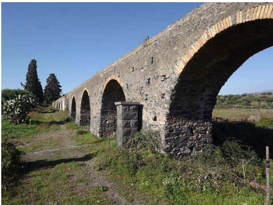
Fig. 7-8 Località C.da Pantano, ex feudo Valcorrente. Resti dell'acquedotto. Arcate ricostruite.
