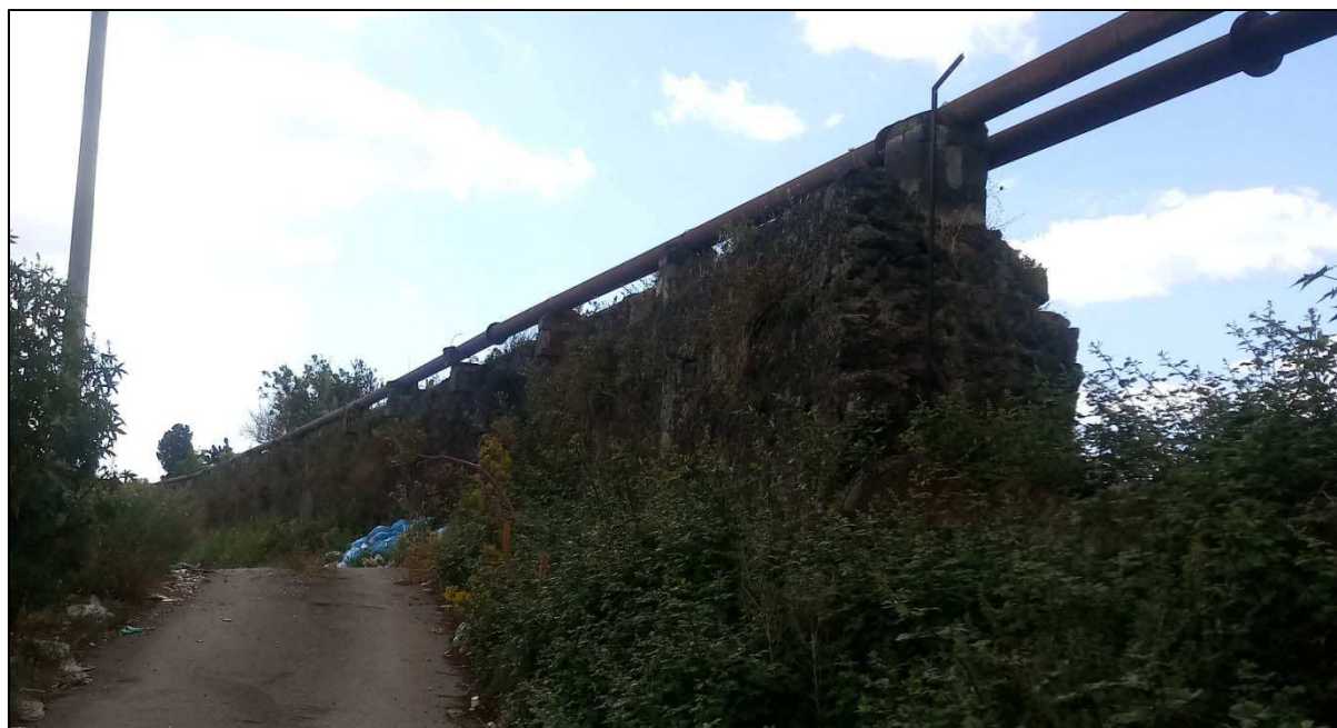
Fig. 7-7 Resti del 2° tratto di acquedotto in località Porrazzo (Presenza archeologica n. 40.3).
