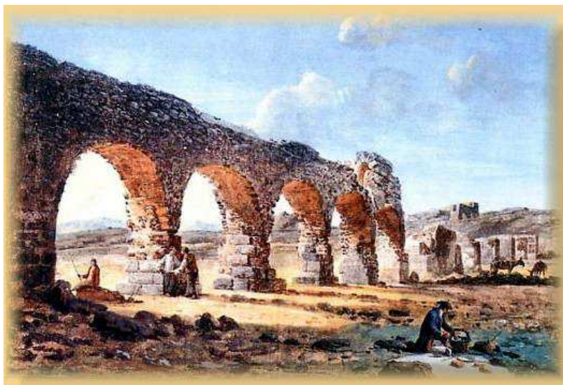
Fig. 7-5 Resti dell'acquedotto forse nei pressi di contrada Scalilli a Paternò, in un acquerello di Jean Houel.
