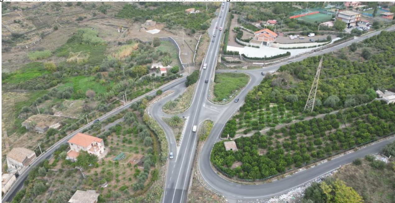
Figura 2-4 Svincolo di Paternò esistente
