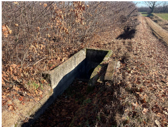
Figura 4 – Tratto di collegamento tra le cabine
