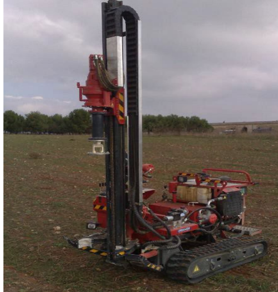
Figura 35 - MACCHINA BATTIPALO PER INFISSIONE PALI.
