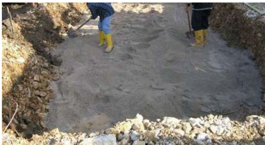
Figura 31 - SBANCAMENTO PIANO POSA CABINE
