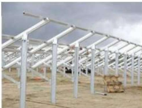
**Figura 6 - strutture di sostegno fissa**
