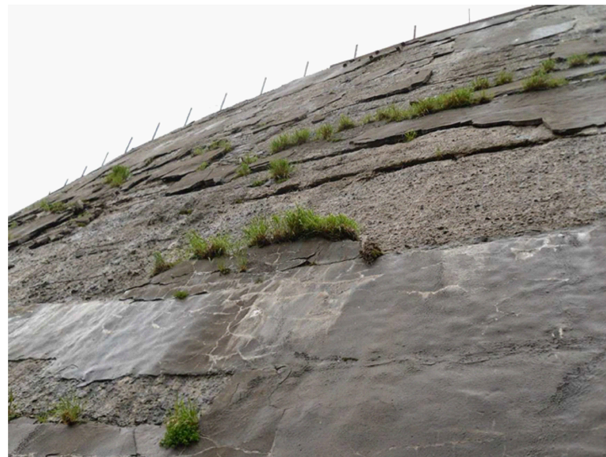
PARTICOLARE DEL PARAMENTO DI MONTE
