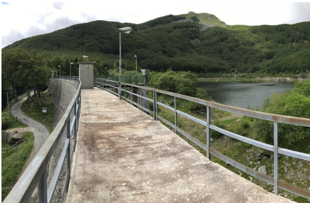
Figura 3.14 Coronamento della diga
