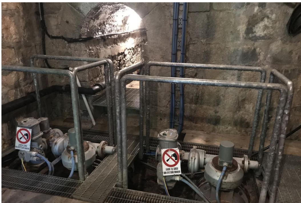
Figura 3.20 Camera di manovra
