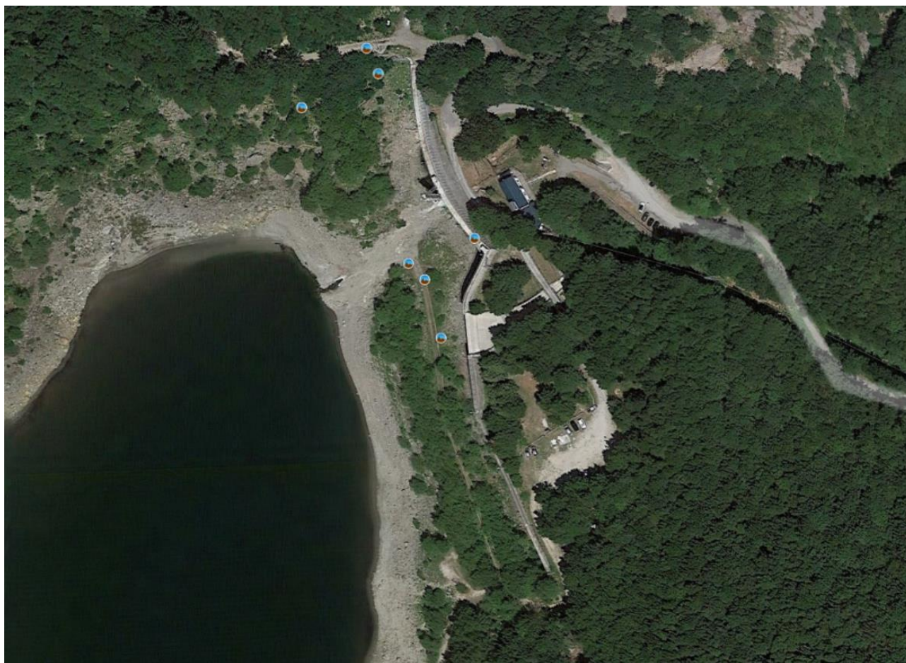
Figura 9.1 Vista aerea dello sbarramento
