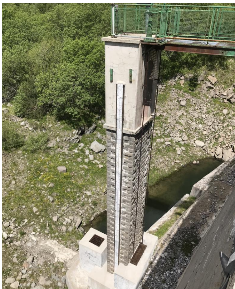
Figura 3.19 Torre di manovra
