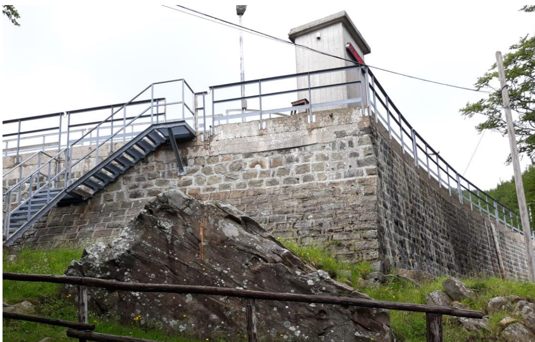
Figura 3.15 Paramento di valle della diga
