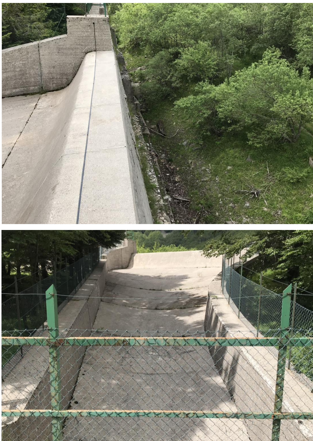
Figura 3.16 In alto la soglia dello scarico di superficie. In basso il canale fuggatore dello scarico di superficie
