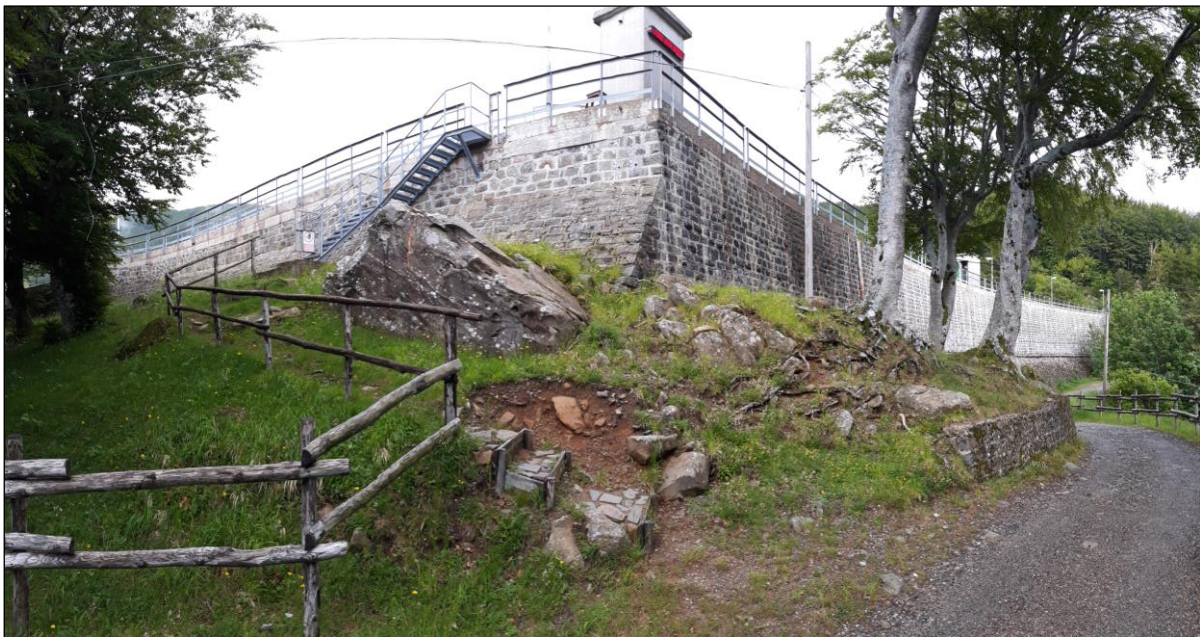
Figura 1.3. Foto del corpo diga: lato valle
