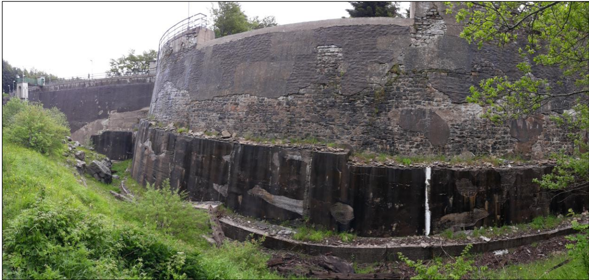
Figura 1.2. Foto del corpo diga: lato monte
