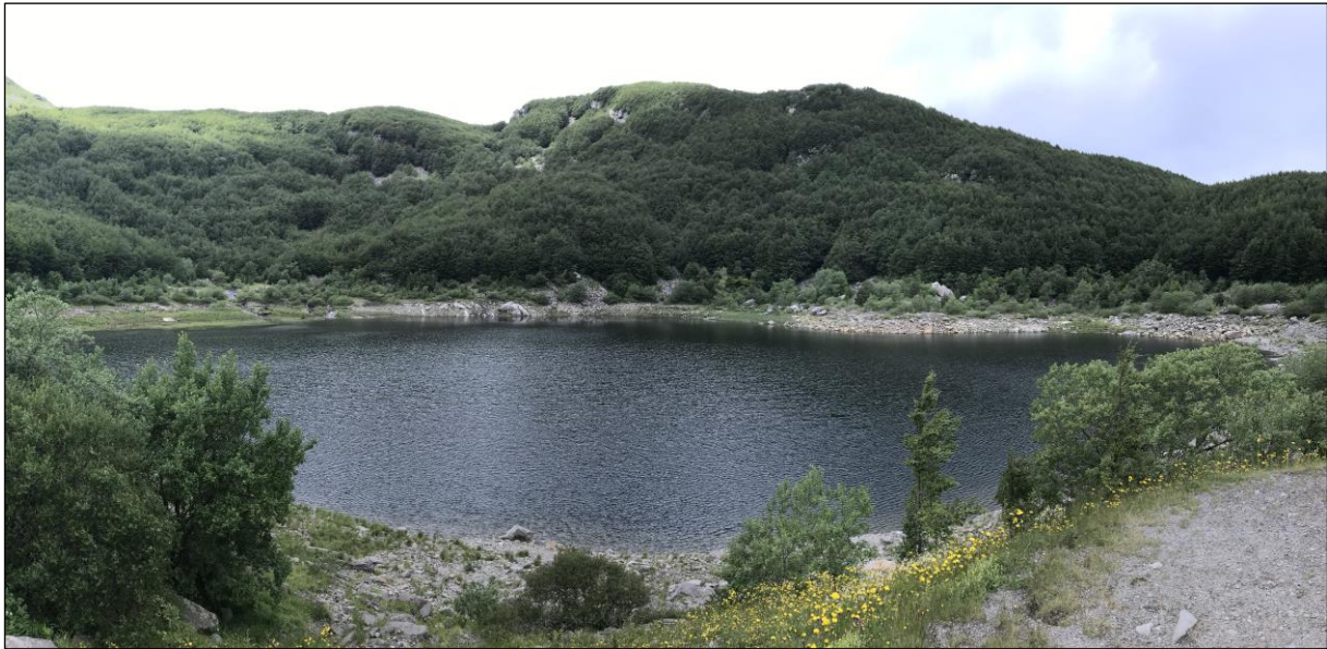
Figura 4.9 Vista d'insieme del Lago di Ballano dal coronamento della diga, con particolare riferimento ai versanti a media-elevata acclività che circondano l'invaso. Le sponde che bordano il lago risultano essere caratterizzate dalla presenza di depositi di versante e di origine glaciale che ne addolciscono localmente le pendenze e ricoprono il substrato arenaceo-pelitico
