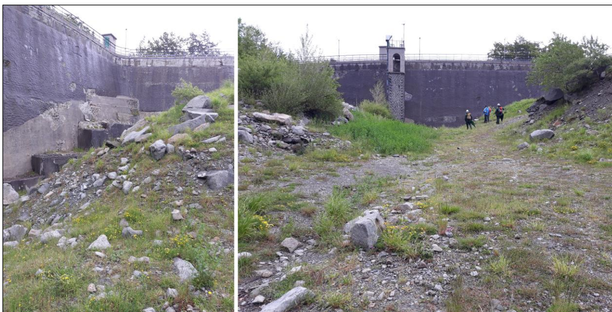
Figura 4.7 Vista sulla porzione centro-settentrionale a monte dello sbarramento, con particolare dei depositi detritici di origine gravitativa che ricoprono la formazione arenaceo-pelitica del Macigno sottostante. Le immagini evidenziano la natura caotica e la tessitura eterogenea dei depositi di versante che caratterizzano i versanti nordoccidentali dell'invaso e l'area settentrionale dello sbarramento. Tali depositi sono costituiti da accumuli di clasti eterometrici a struttura caotica immersi in una matrice sabbioso-limosa talora argillosa
