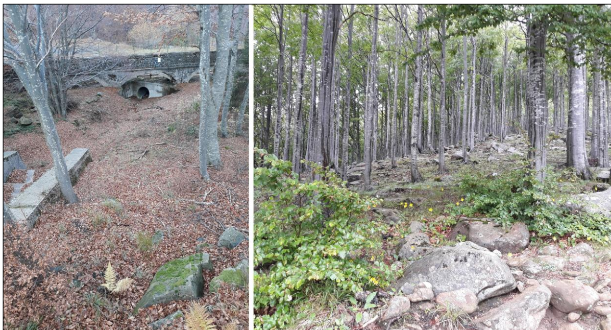
Figura 4.8 Viste dell'area a valle dello sbarramento nella zona dello sfioratore (immagine di sinistra) e sulla spalla destra (immagine di destra), caratterizzate dalla presenza dei depositi di origine glaciale con clasti eterometrici e frequenti blocchi inglobati in una matrice sabbioso-limosa e limoso-sabbiosa
