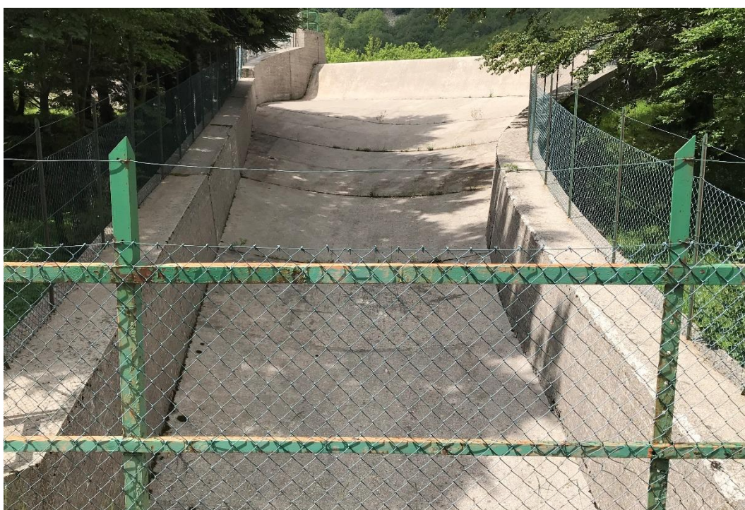
Figura 3-13 In alto la soglia dello scarico di superficie. In basso il canale fuggatore dello scarico di superficie
