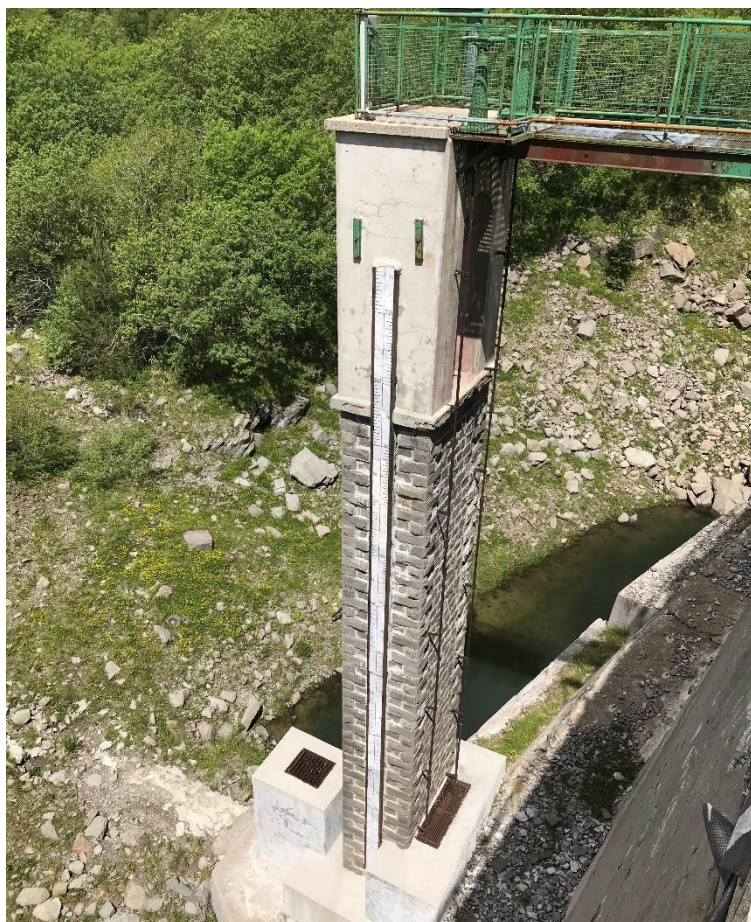
Figura 3-16 Torre di manovra
