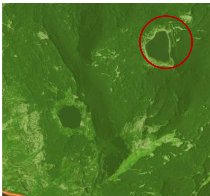
Figura 2-3 - Localizzazione dello sbarramento di Lago Ballano rispetto all'area dichiarata di notevole interesse pubblico ai sensi dell'art. 136 del D. lgs. 42/2004 (webgis regione Emilia-Romagna)
