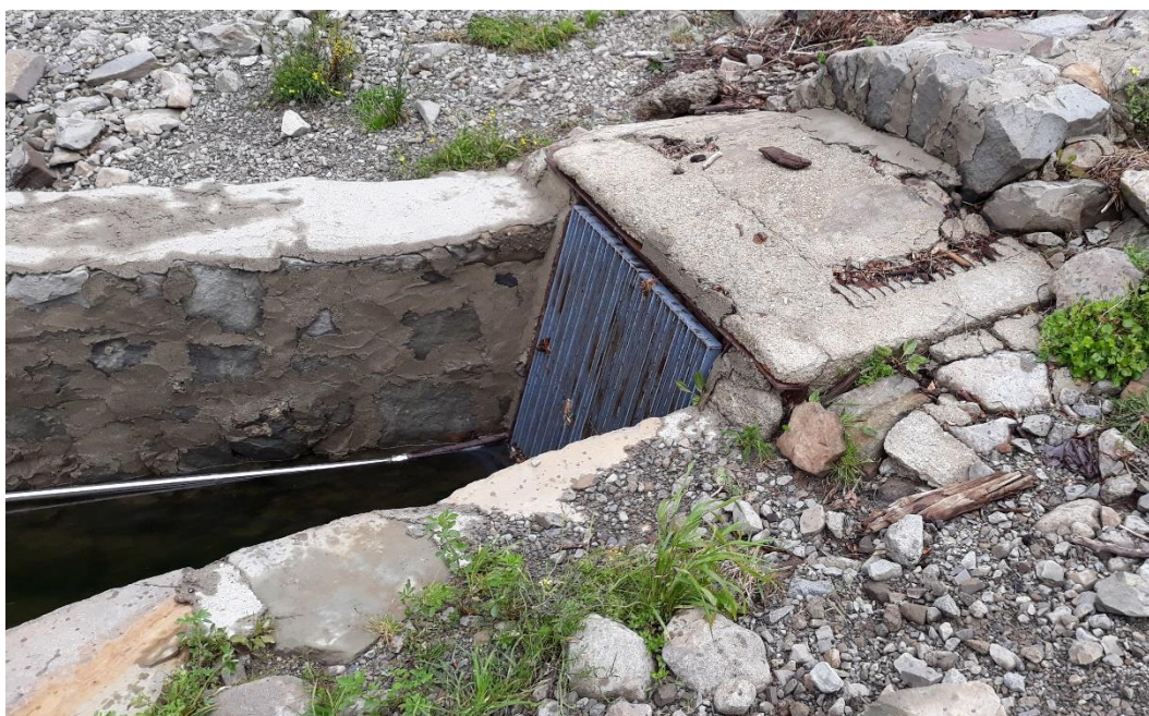
Figura 3-15 Imbocco dello scarico di fondo e opera di presa
