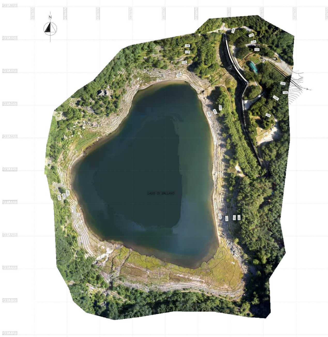
Figura 3-1 Vista aerea dello sbarramento esistente
