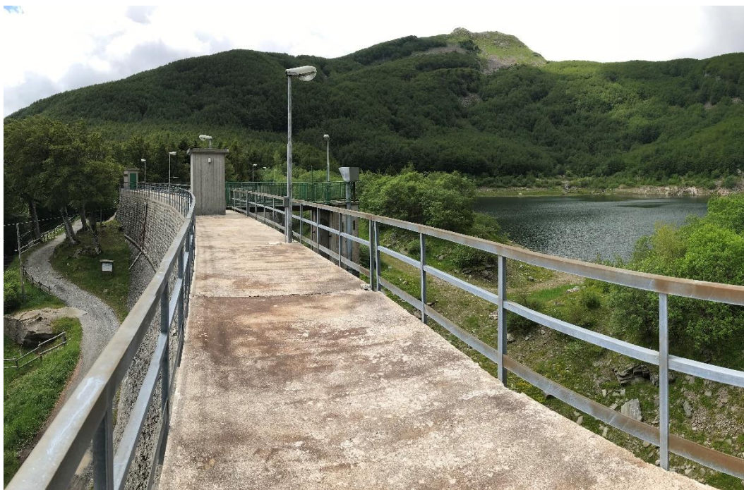
Figura 3-11 Coronamento della diga
