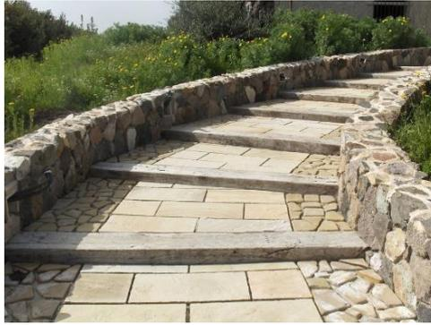
**Figura 25 - Rivestimento della scala di accesso alle banchine ed alle terrazze**
