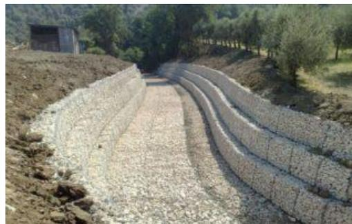
**Figura 28 - Sistemazione del fondo di un canale con gabbioni e materassi**
