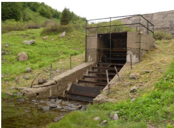
Figura 20 Imbocco dello scarico di fondo
