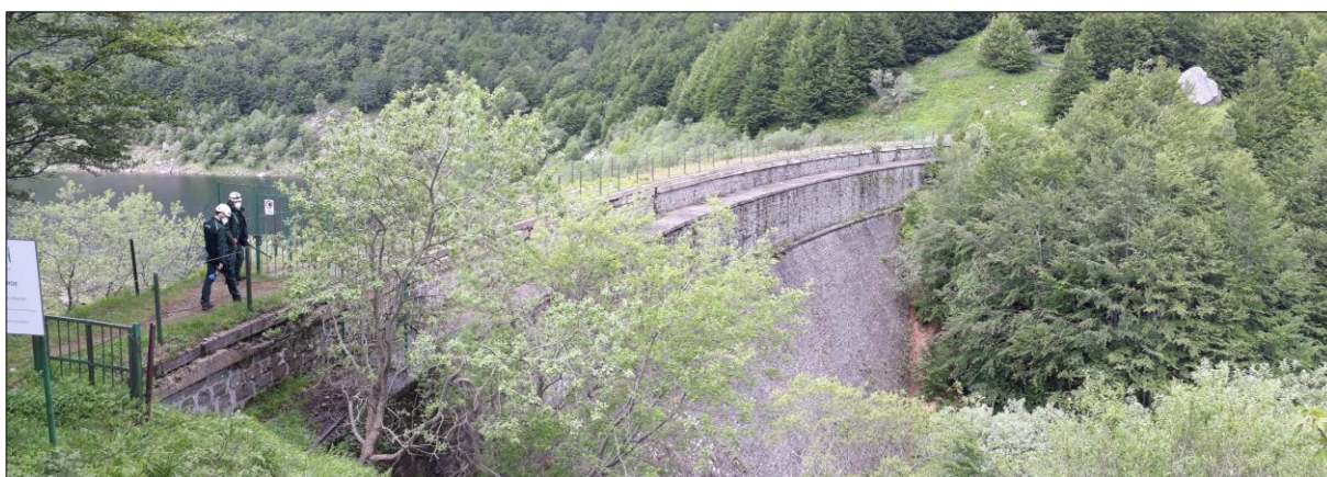
Figura 1.3. Foto del corpo diga: lato valle
