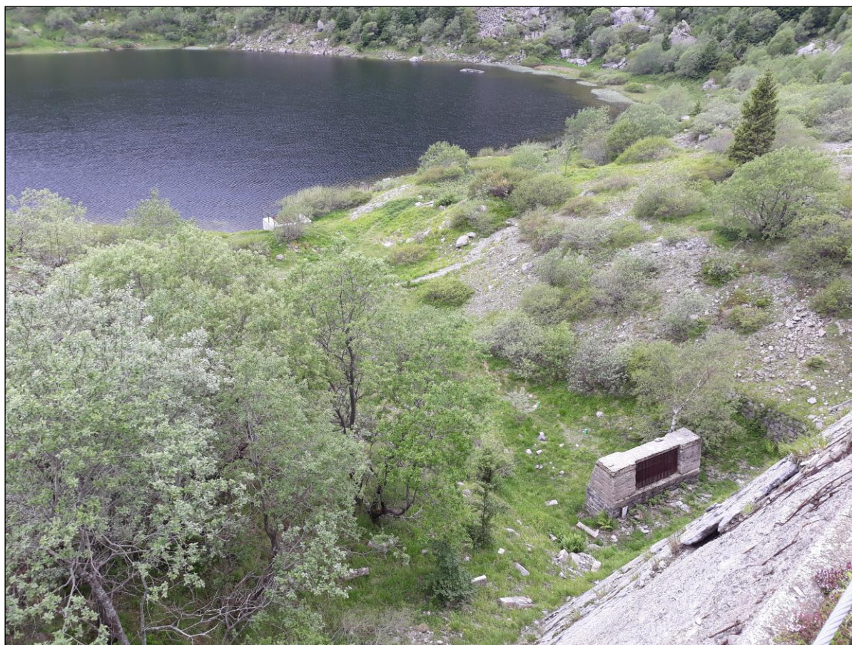
Figura 4.7 Vista sulla porzione immediatamente a monte dello sbarramento, con particolare dei depositi detritici di origine glaciale che ricoprono la formazione arenaceo-pelitica del Macigno sottostante e caratterizzano l'area dell'imposta e la sponda destra dell'invaso. Le immagini evidenziano la natura caotica e la tessitura eterogenea dei depositi di origine glaciale in esame. Tali depositi sono costituiti da accumuli di clasti eterometrici a struttura caotica immersi in una matrice sabbioso-limosa talora argillosa
