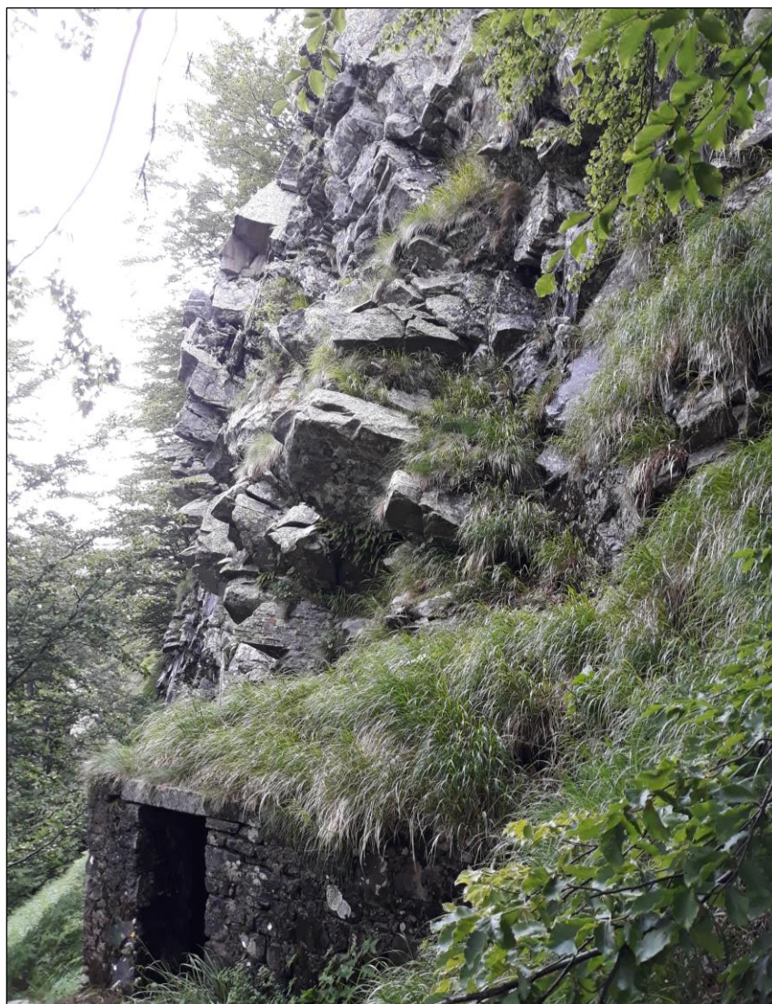
Figura 4.9 Particolare di un affioramento della Formazione del Macigno nell'area a valle dello sbarramento lungo la strada che da Lago Verde conduce a Lago Ballano. Si tratta di torbiditi arenacei ed arenaceo – pelitici grigi con granulometria da media a medio – fine negli strati meno spessi e da grossolana a molto grossolana negli strati spessi, a cui sono subordinati livelli pelitici, costituiti da siltiti grigie, marne siltose ed argilliti grigie
